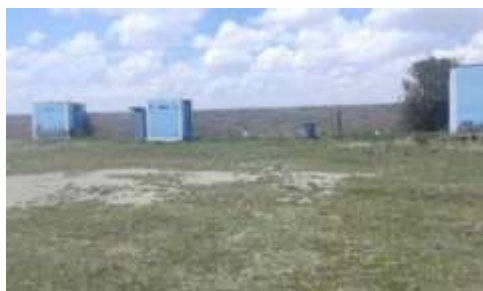
Área dentro de la Institución Educativa, para la eliminación de los residuos sólidos
