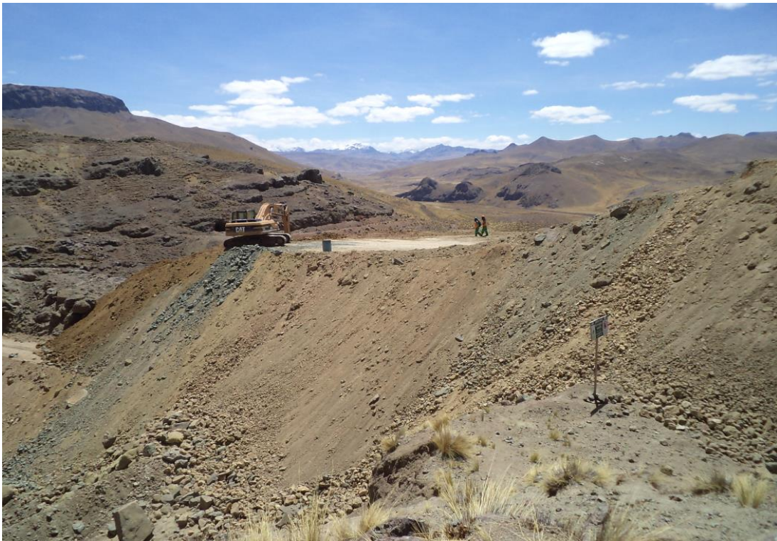
Figura 28. Cantera de Desmonte.
