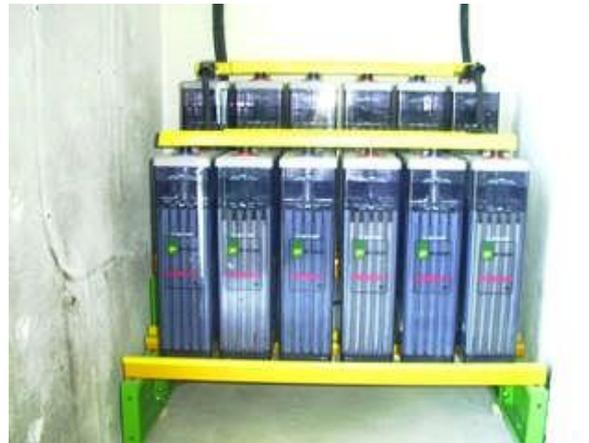
*Figura 14.* Baterías de plomo - ácido.
