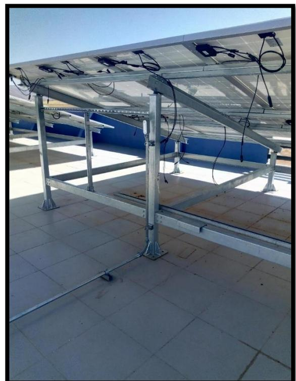
**Se tiene 8 sistemas independientes y todos estos conectados a la entrada de su respectivo inversor de potencia nominal de 3000 W del fabricante SOLAR EDGE, modelo SE3000H.**
