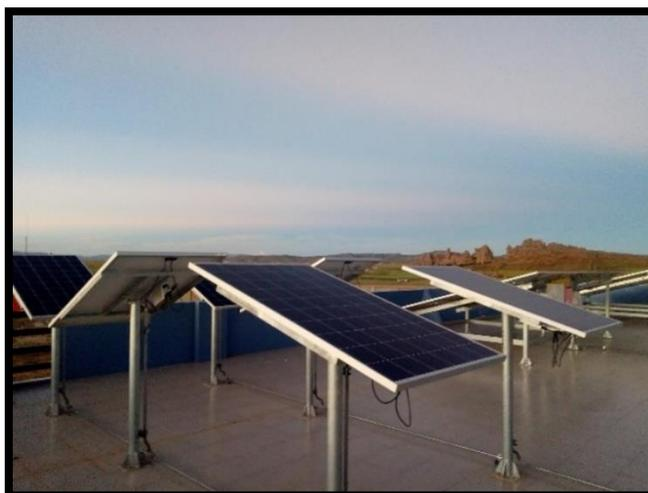
Armado y cableado de los micro inversores, adecuando la inclinación de los paneles fotovoltaicos 4 unidades hacia el norte y cuatro unidades hacia el sur; así mismo en estos paneles se consideran 4 sucias y 4 limpias, tal como se muestra en el plano general.
