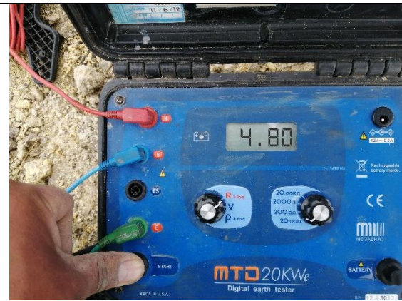
Foto 38.- Medición después de la mejora 4.80 \Omega
