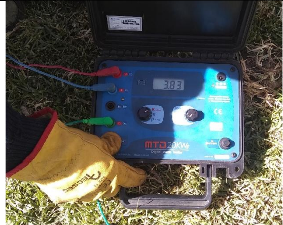
Foto 18.- Medición después de la mejora 3.80 \Omega
