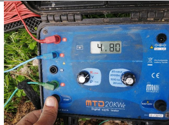
Foto 40.- Medición después de la mejora 4.80 \Omega
