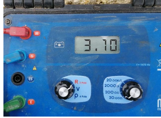
Foto 54.- Medición después de la mejora 3.10 \Omega
