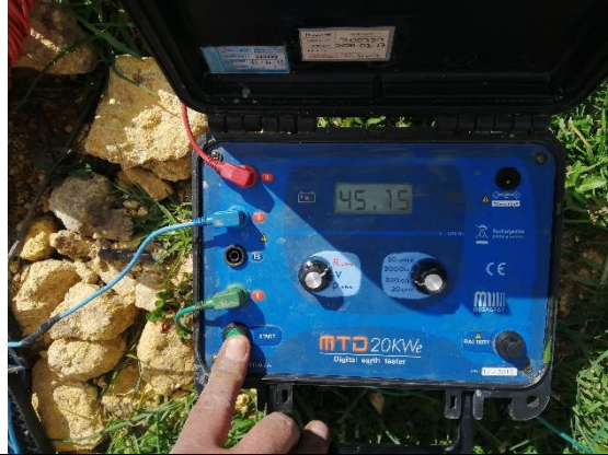
Foto 23.- Medición antes de la mejora 45.15 \Omega
