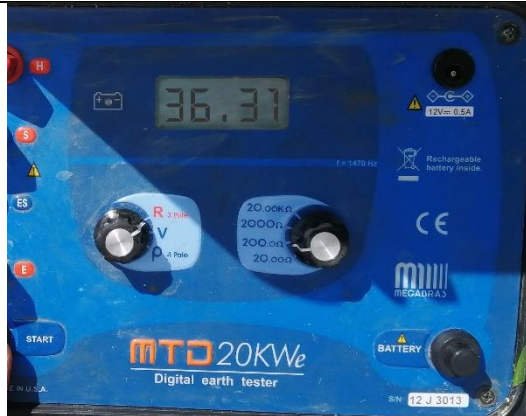
Foto 45.- Medición antes de la mejora 36.31 \Omega
