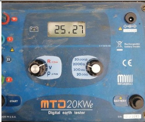
Foto 11.- Medición antes de la mejora 25.27 Ω
