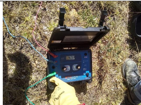
Foto 22.- Medición después de la mejora 4.70 \Omega
