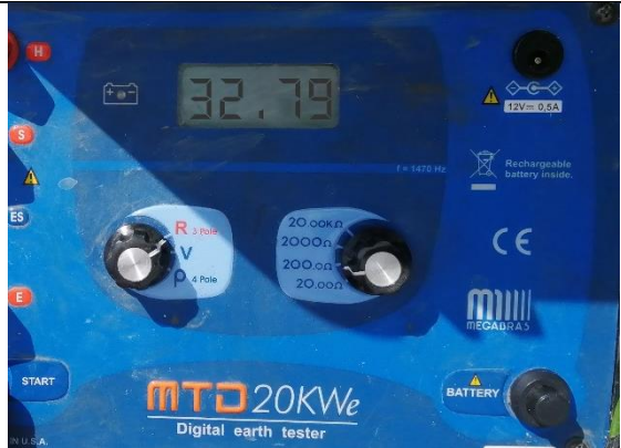
Foto 49.- Medición antes de la mejora 32.79 Ω
