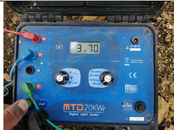
Foto 20.- Medición después de la mejora 3.70 \Omega
