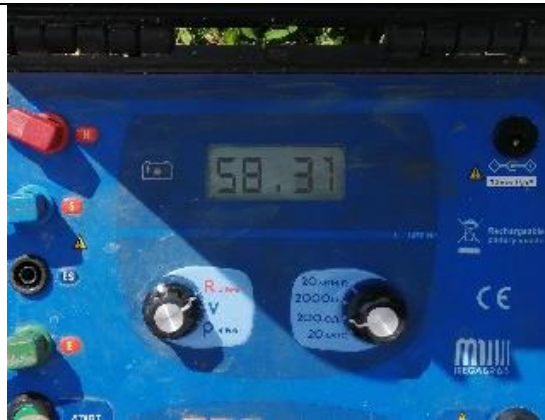
Foto 25.- Medición antes de la mejora 58.31 \Omega
