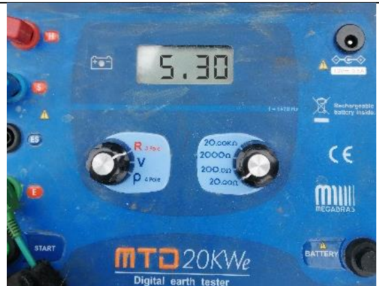
Foto 28.- Medición después de la mejora 5.30 \Omega
