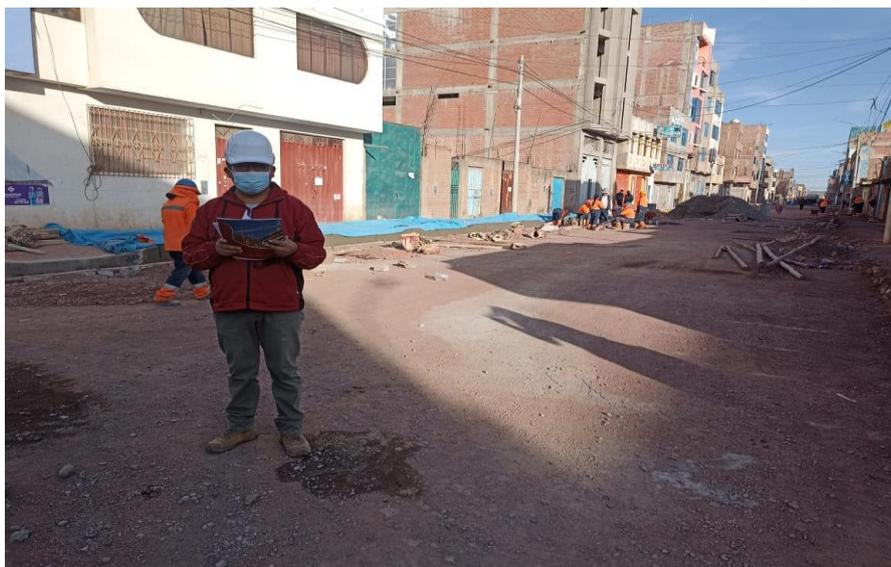
**Figura 4.** Rollizos de madera sin señalización.
