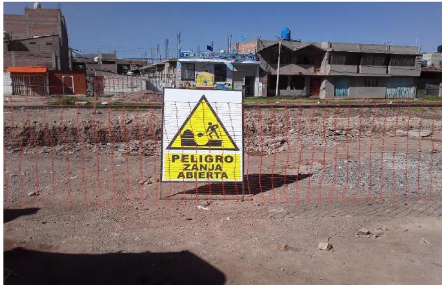
**Figura 3.** Enmallado y letrero de seguridad al extremo de la excavación de zanjas.
