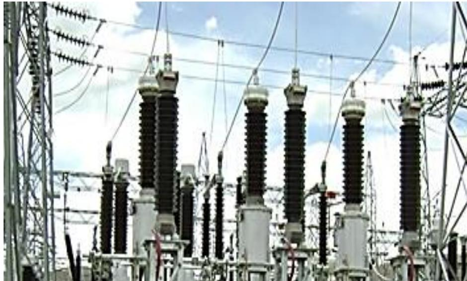
*Figura 6.* Seccionadores de Barra, Interruptores de Potencia S.E. Huancané.
