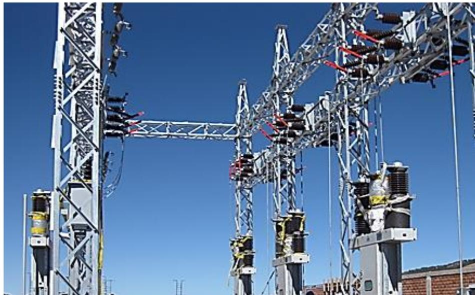
*Figura 5.* Seccionadores de Barra, Interruptores de Potencia S.E. Huancané.
