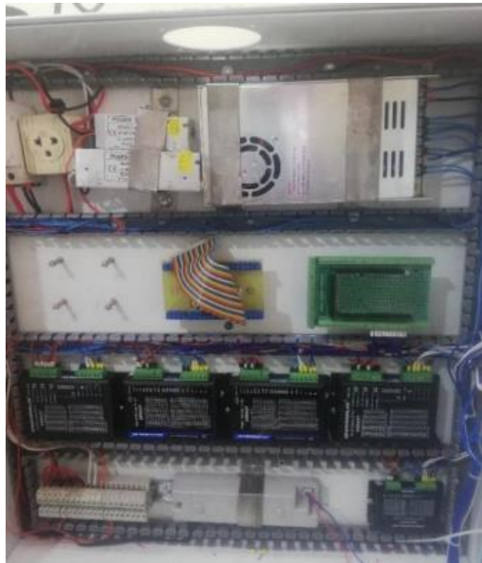
Figura 114: Cableado y conexión de los componentes de control
