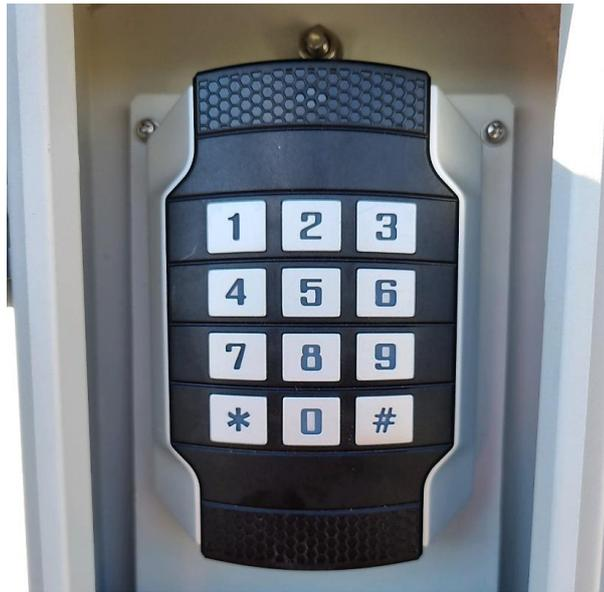
**Figura 39:** Lector de Tarjetas RFID Instalada en Caja.
