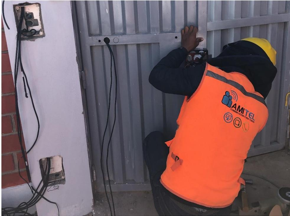
**Figura 32:** Instalación de la Cerradura Eléctrica SG0608-Z.
