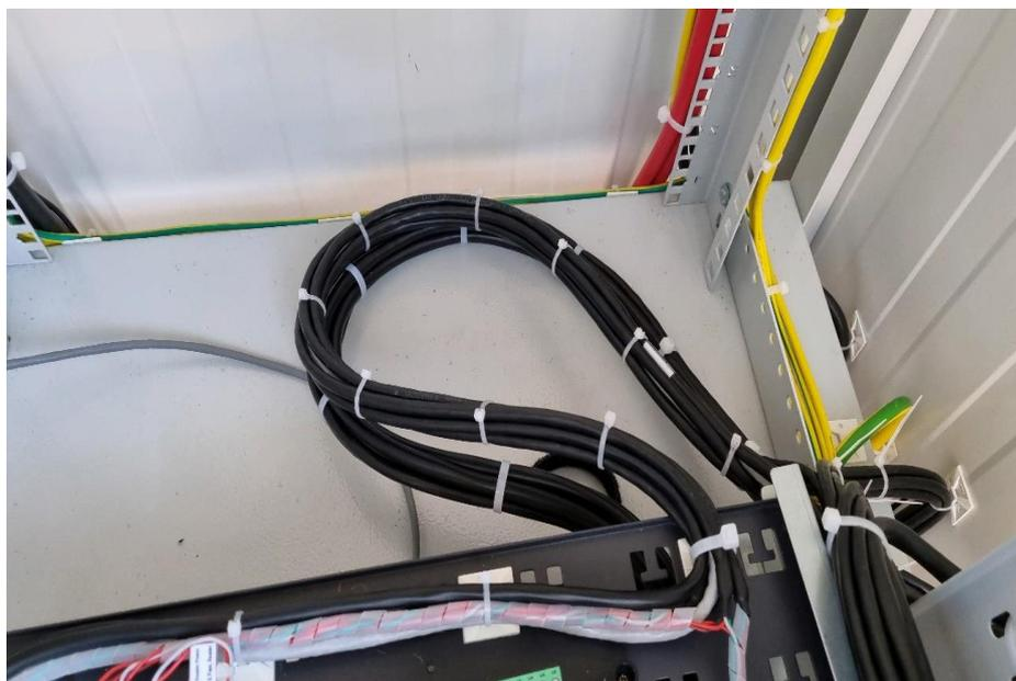
**Figura 37:** Peinado de los cables en Rack al ZXNVM-K2601.
