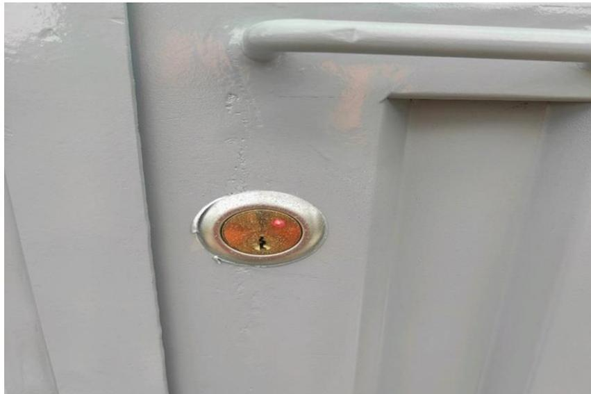
**Figura 72:** Led Indicador de la Cerradura Eléctrica con Puerta Cerrada.
