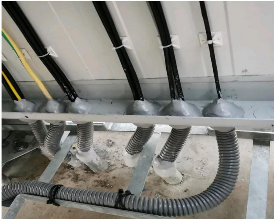
**Figura 36:** Acabado y Sellado de los Cables de Conexión.
