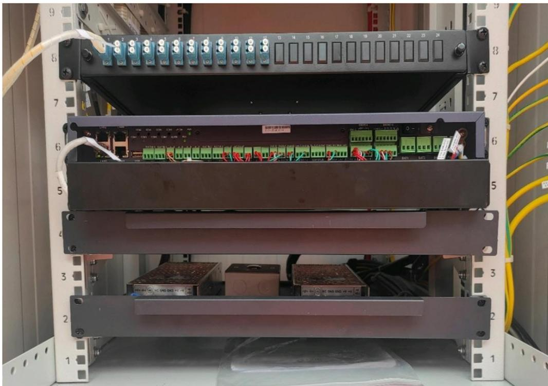
**Figura 59:** Bandejas y Equipos, ZXNVM-K2601 en Rack.
