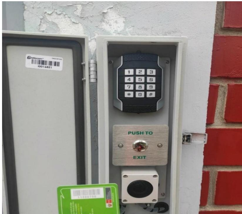
**Figura 70:** Tarjeta de Ingreso y Lector RFID.
