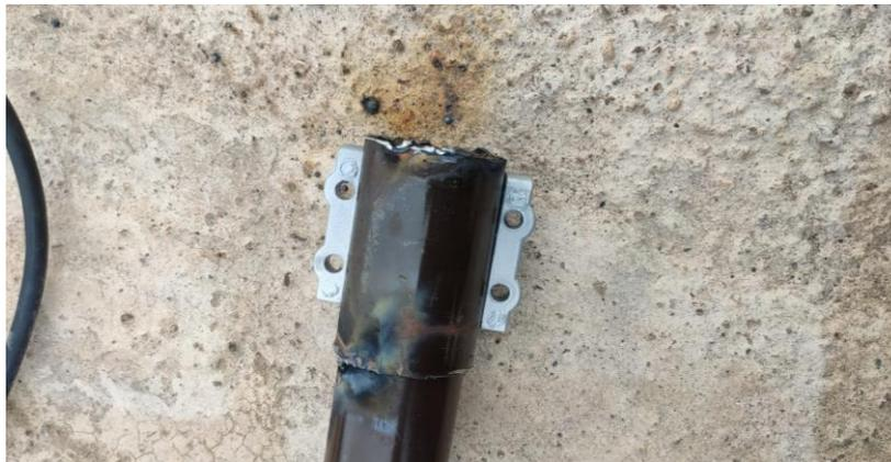
**Figura 31:** Estructura para reposar el generador eólico.
