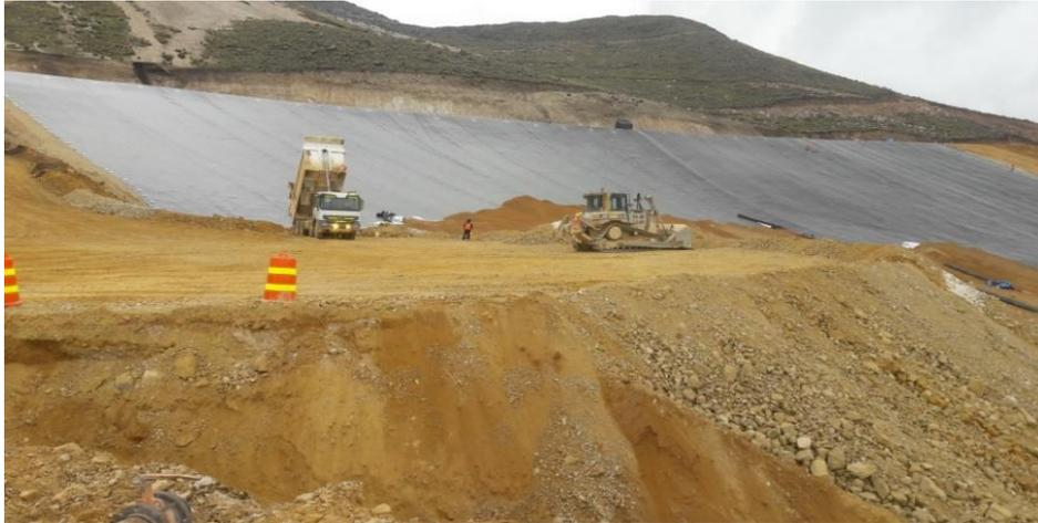
**Figura 16.** Terminado su ciclo de riego, se retira el sistema de riego para dar paso al llenado de nuevo mineral.
