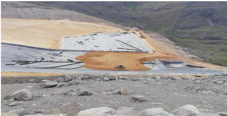
**Figura 14.** Tuberías laterales y principales perforadas de HDPE de doble pared de 100 a 300 mm Ø de diámetro.
