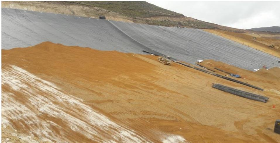
**Figura 13.** Pad de piso inclinada para que la solución se drene en una sola salida
