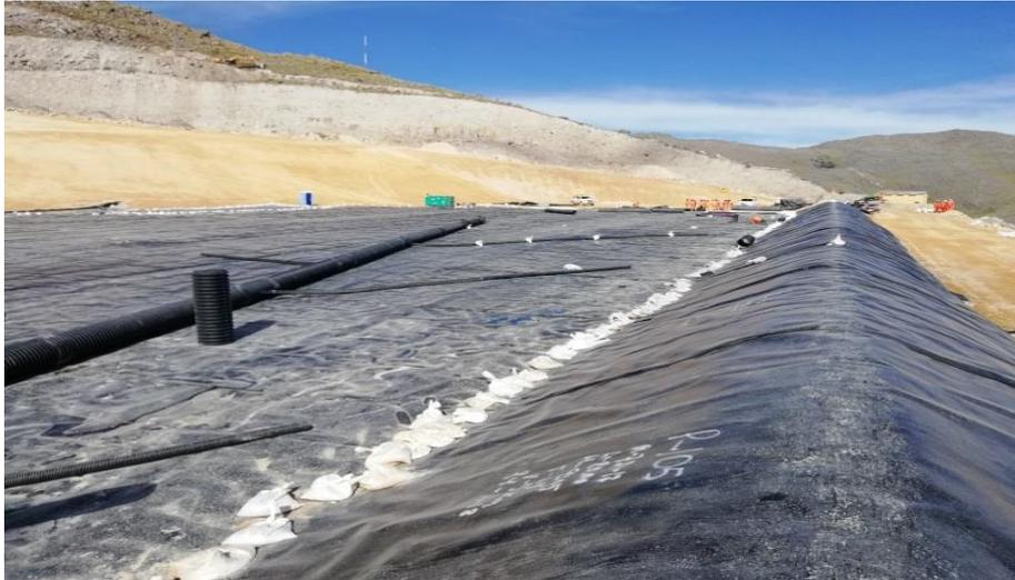
**Figura 11.** Capa de geomembrana de polietileno del tipo HDPE
