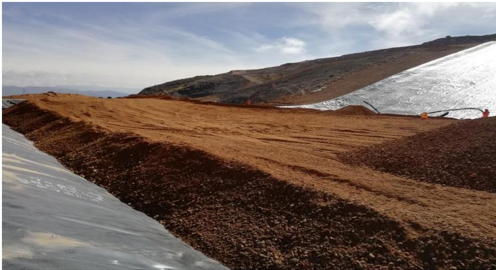
**Figura 12.** Capa de material llamada over liner
