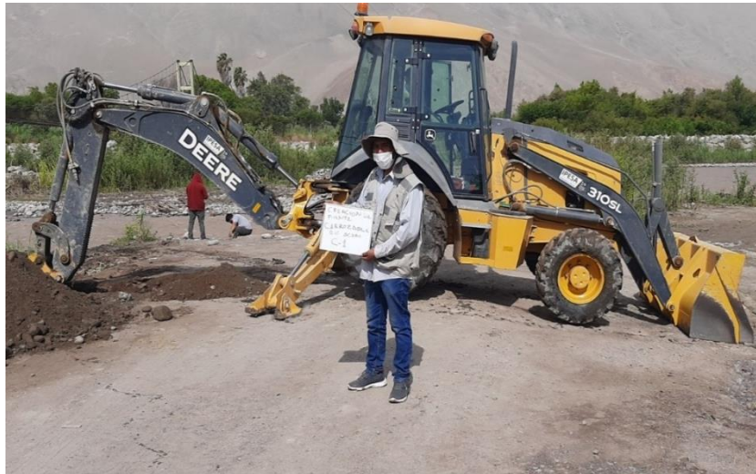
Fotografía 1 Excavación de la calicata C-1
