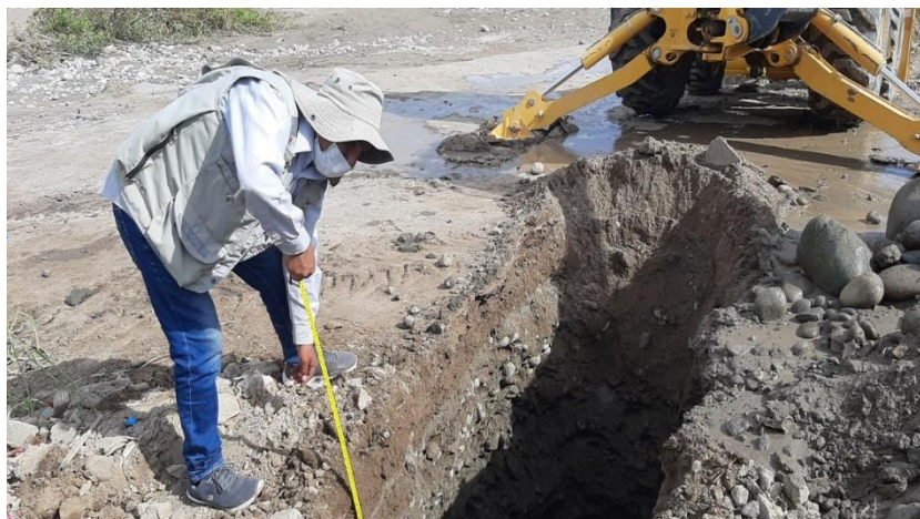
Fotografía 3 Excavación de la calicata C-2
