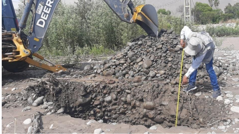
Fotografía 5 Excavación de la calicata C-4
