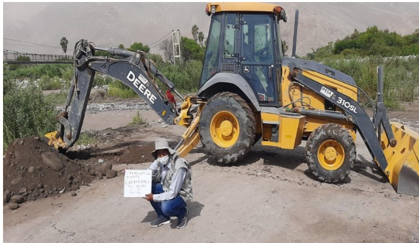
Fotografía 2 Excavación de la calicata C-1
