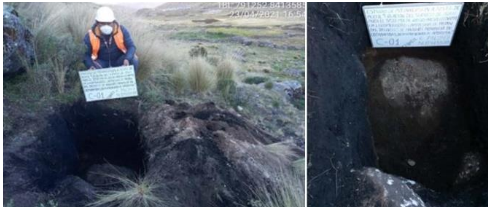
Figura N° 40 Fotografía de la Calicata C-01
