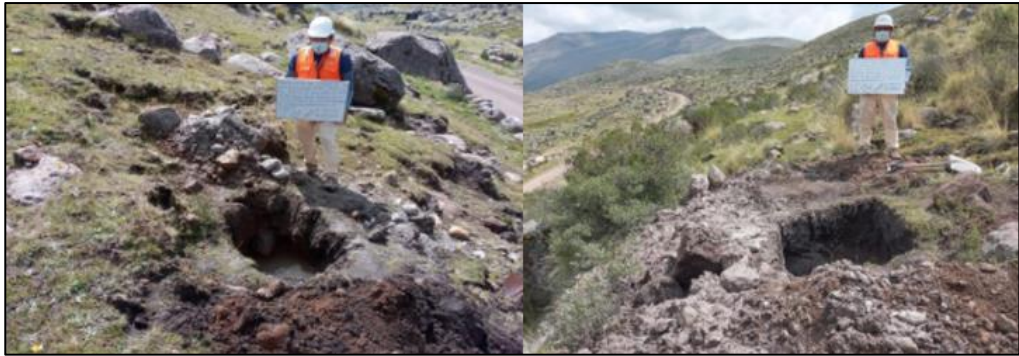
Figura N° 18 Excavación de calicatas realizadas en el in-situ
