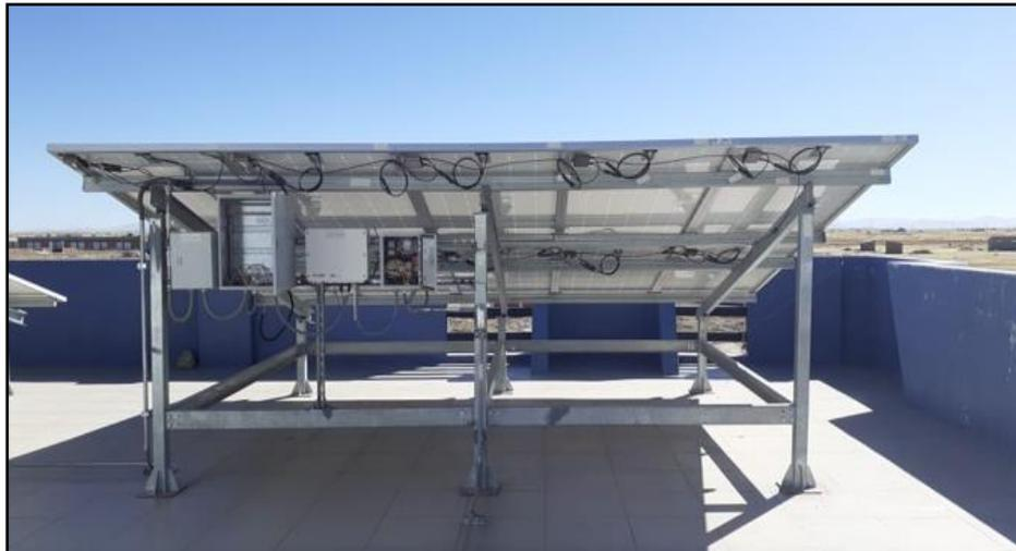
Figura 14. Instalación fotovoltaica con convertidores cc/cc
