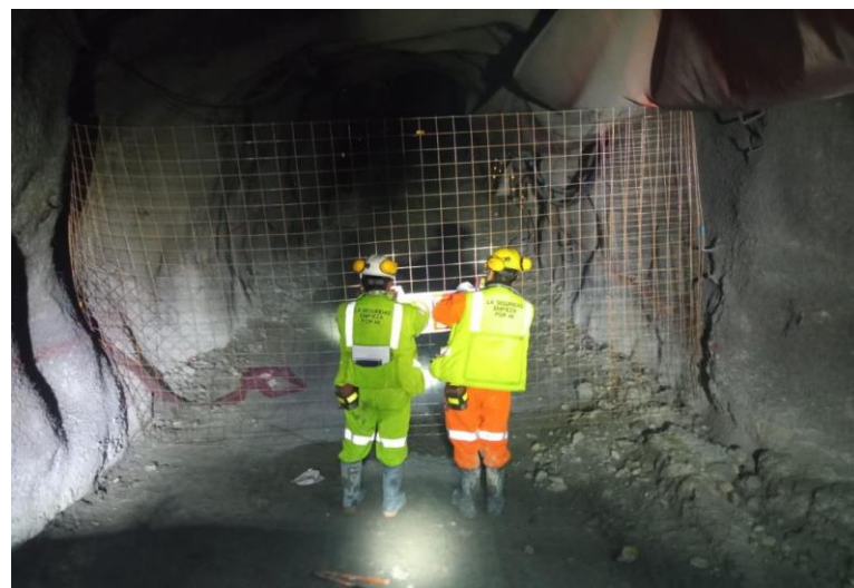
Figura 22. Uso de equipo de protección personal
