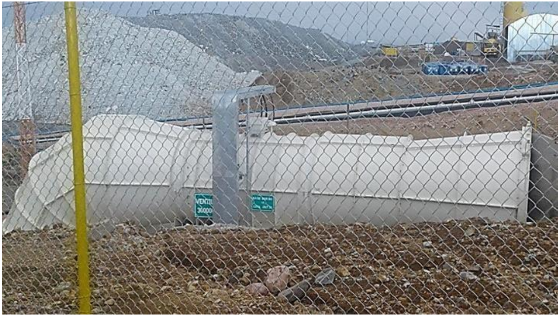
Figura 15. Ventilador principal 300 000 CFM
