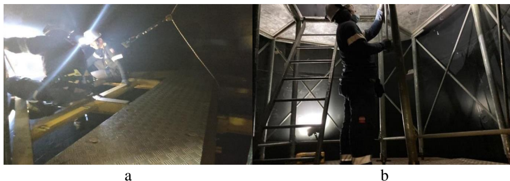
Figura 7. (a) y (b) Montaje de plataforma de mantenimiento y montaje de plataforma para inspección de rodete
