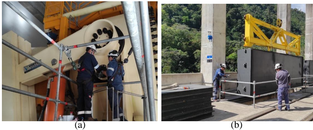
Figura 4. (a) y (b) Cierre de válvula esférica y bloqueo general
