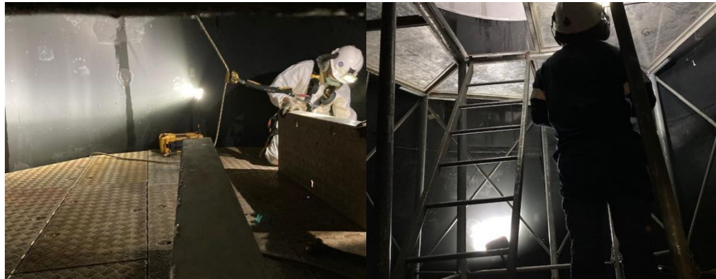
Figura 11. (a) y (b) Montaje de plataforma de mantenimiento cono de succión y montaje de plataforma para inspección de rodete.
