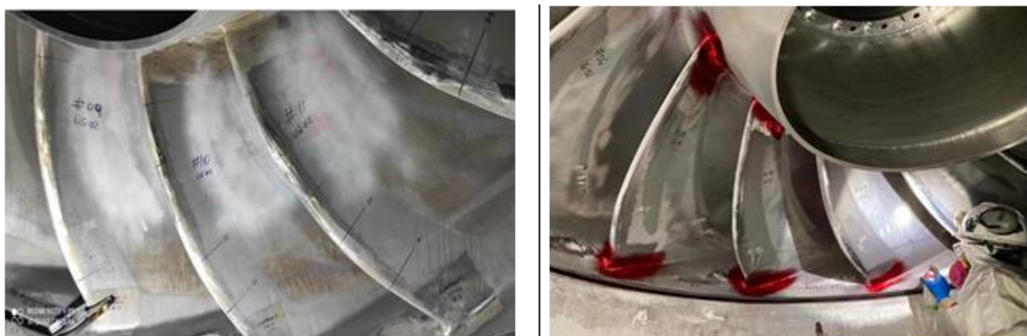
Figura 15. Ensayos de líquidos penetrantes al rodete UG-2
