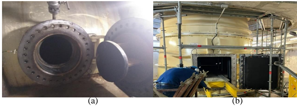
Figura 5. (a) y (b) Apertura de la cámara aspiral y apertura del cono de succión.
