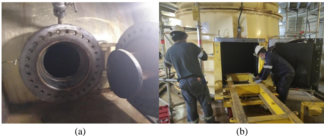
Figura 9. (a) y (b) Apertura de la cámara aspiral y apertura del cono de succión.
