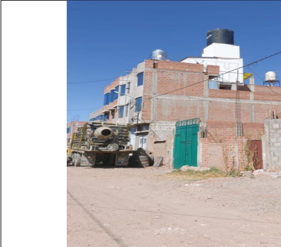
Fig. N° 09: Suministro en evaluación ubicada en el Jr. Huancané.
