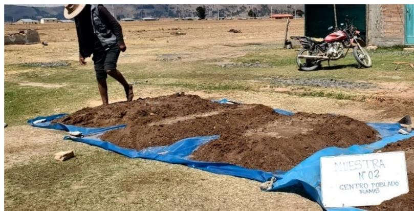
Nota: Mezclado de tierra con agua, para lograr una mezcla uniforme.
