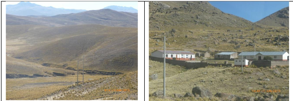
FOTOS 8 Y 9: RED ELECTRICA A TINCOPALCA
