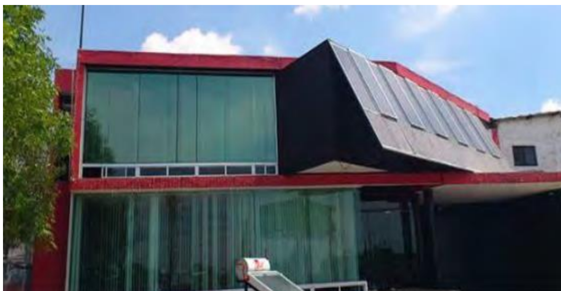
Figura 10. Edificio con fachada fotovoltaica. Fuente: www.saecsaenergiasolar.com
