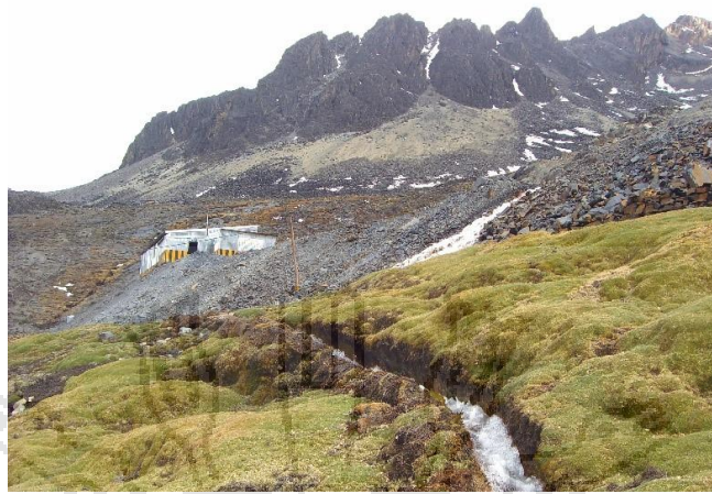
Fotografía 4. Efluente de la Bocamina hacia la poza de sedimentación
