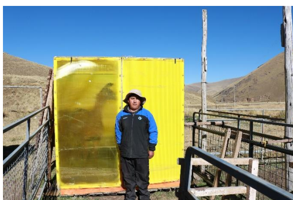
Figura 56. Sellado de la cámara de acumulación de gases.
