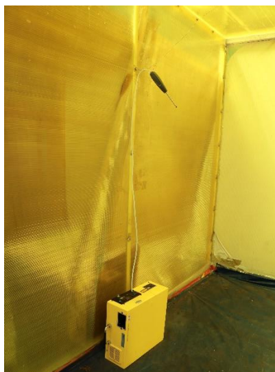
Figura 52. Instalación del equipo gasset DX 4030.
