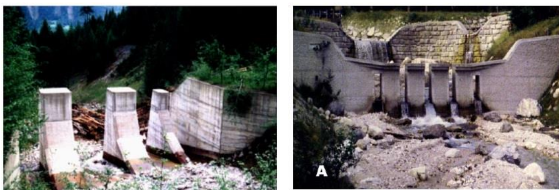
Figura 15 Presas de aperturas verticales Fuente: Montserrat (2005)
