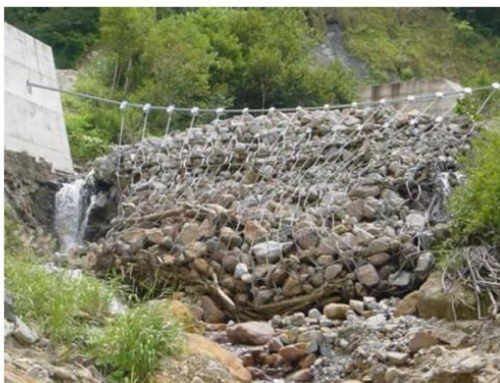
Figura 17 Red Metálica. Mount Tateyama, Japan Fuente: Montserrat (2005)
