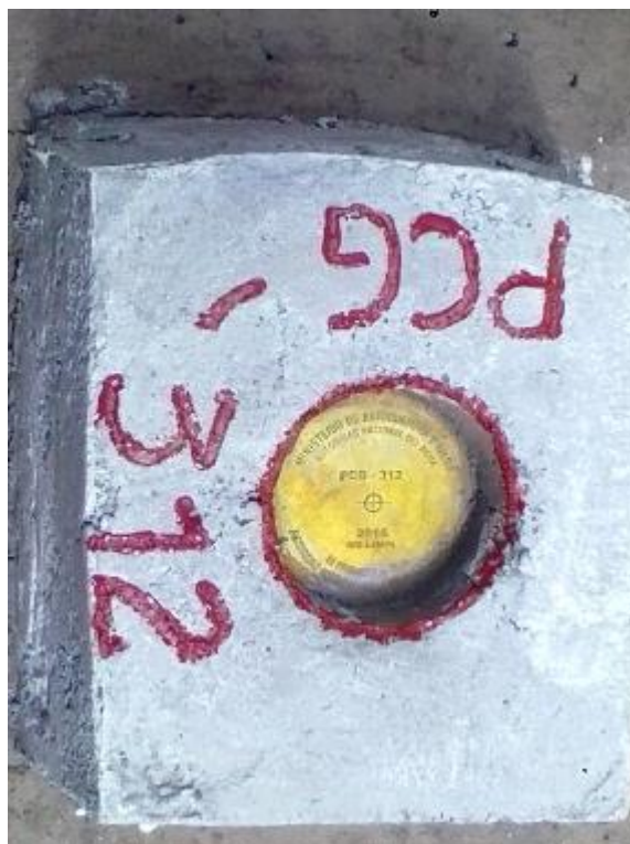
FOTO N° 06: Monumentación y Pintado del Punto de Control Primario PCG –12 en el Río Lampa ubicado en el sector de Lampa – C.P. Tacamani.
