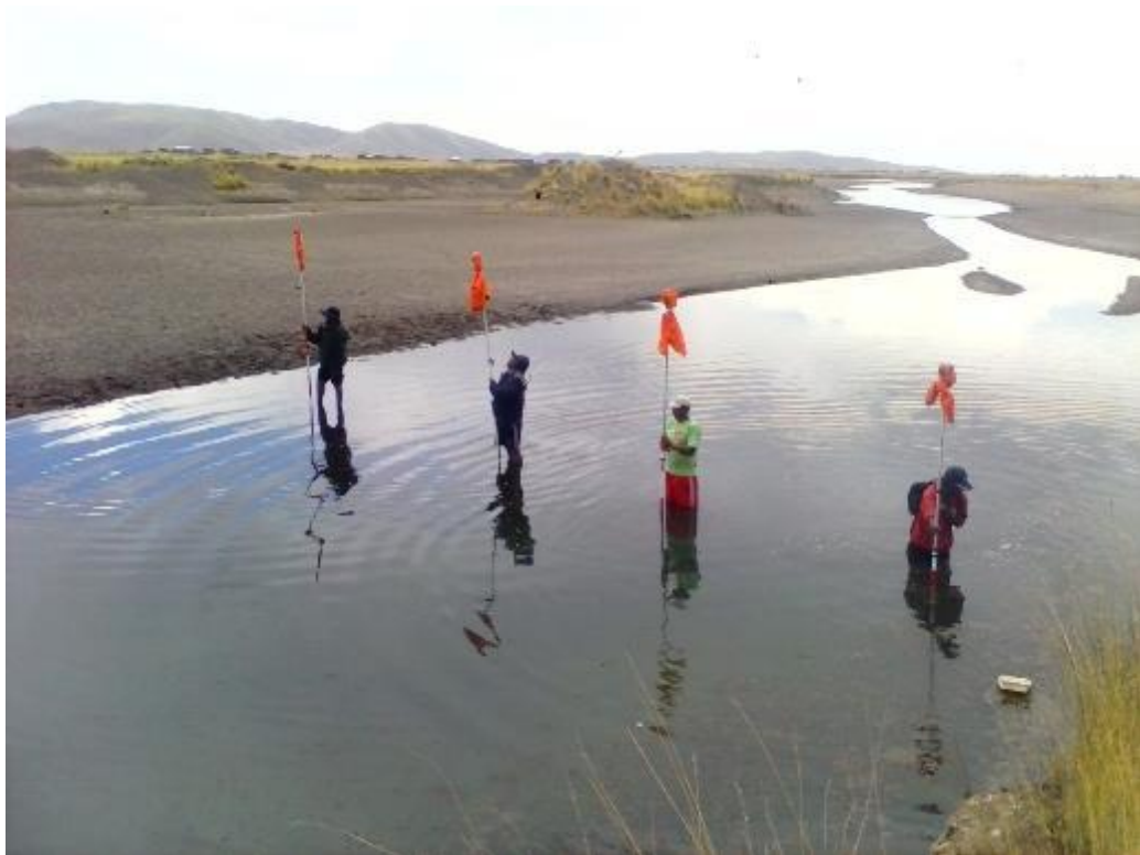
FOTO N° 11: Vista Panorámica de Progresiva 33+000 hasta 34+000 Km. en el Río Lampa ubicado en el sector de Pucachupa - Lampa.
