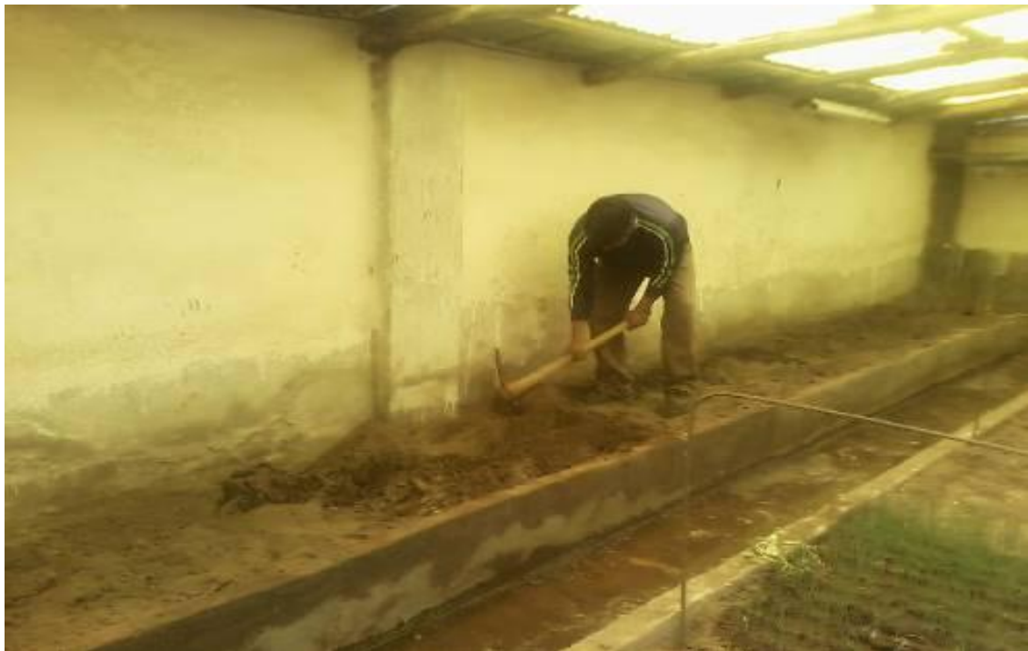
Figura 28. Preparación del terreno.
