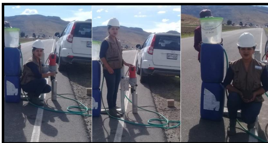
Figura 24. Fotos del instalado de la perforadora diamantina y extracción de muestra en el Km. 16+200.
