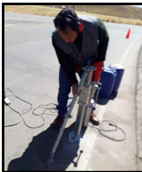
Figura 26. Foto durante la ubicación de equipo de extracción en el punto de toma de muestra.
