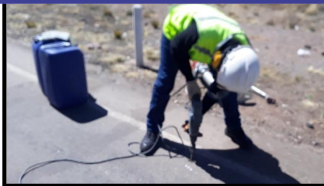
Figura 25. Foto en el proceso de perforado de puntos de fijación del equipo de extracción.
