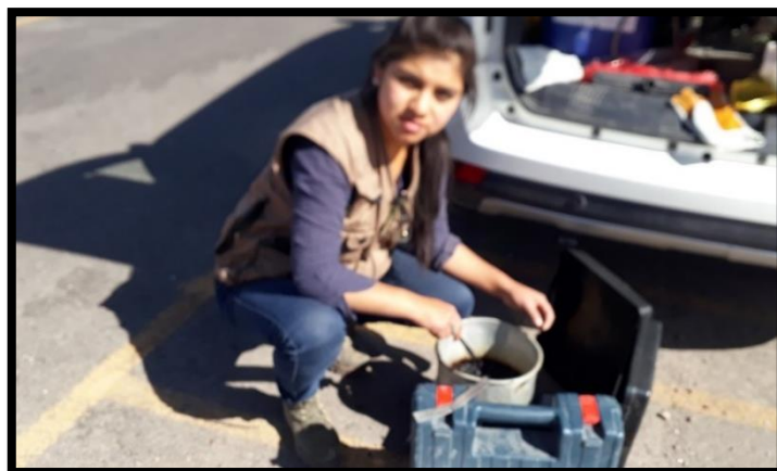
Figura 28. Foto durante la preparación del material asfáltico para la reposición del material extraído.
