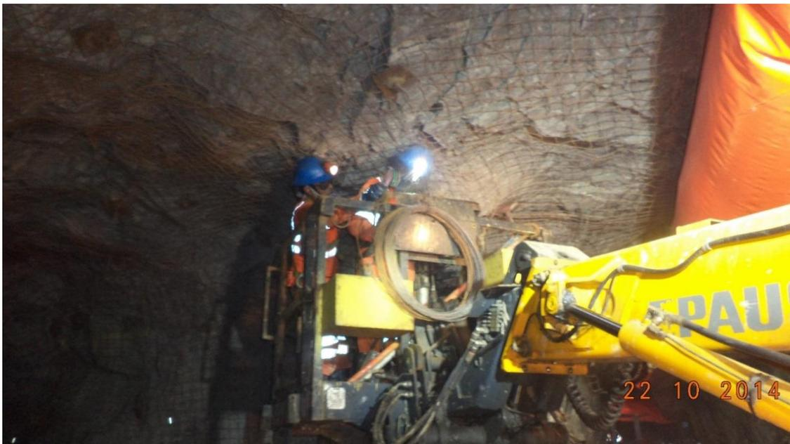
**Anexo 3. Instalación de perno con malla con equipo mecanizado *small bolter***
