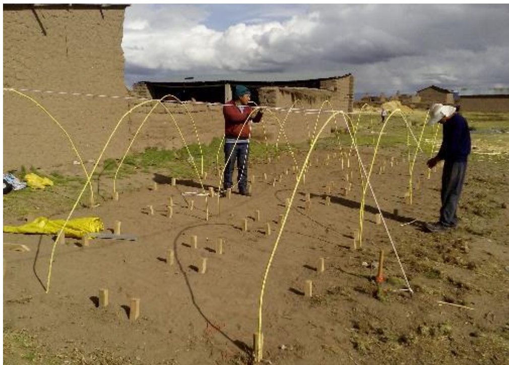
Figura 34. Armado de módulos de FVH.
