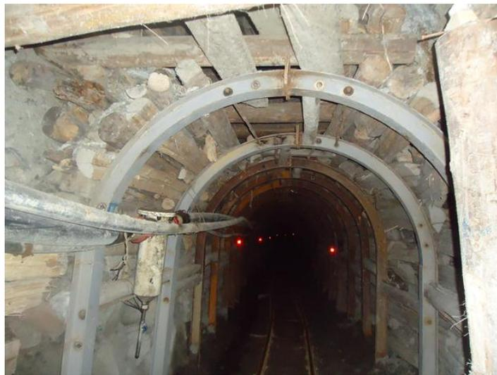
Figura 2. Instalación de cimbras, con distanciamiento en cada metro, en roca tipo IV - III.
