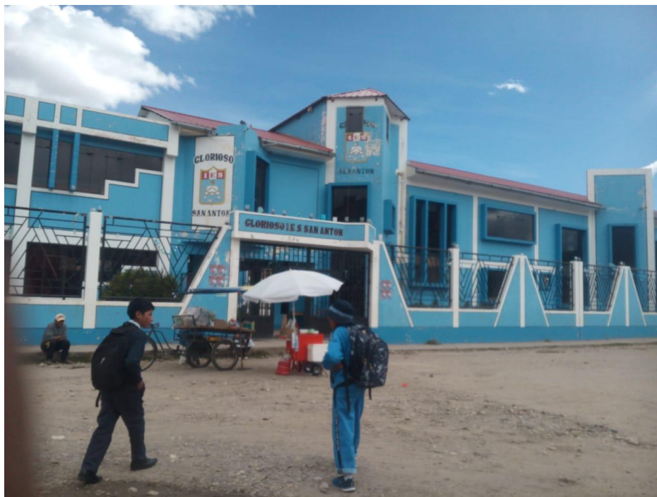
Fotografía 1. Puerta principal de la Institución Educativa Secundaria Glorioso San Antón (toma 1).
