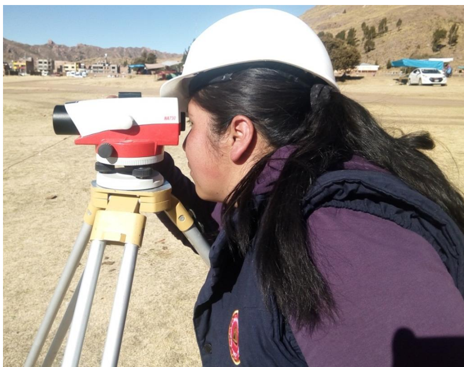
FIGURA N° 19: Nivelación geométrica con nivel automático LEICA NA730
