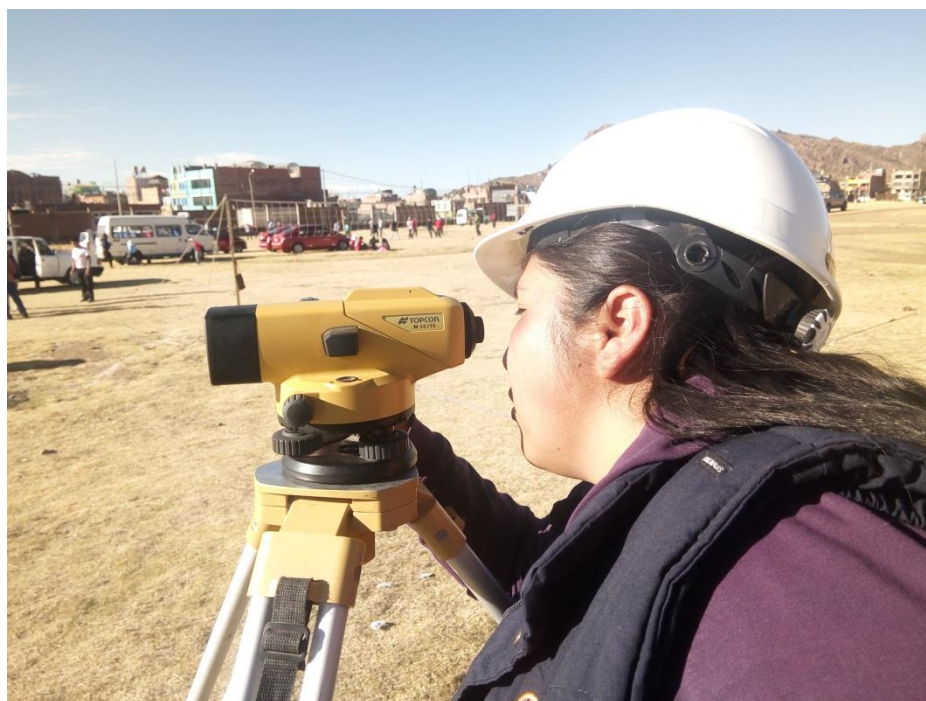
FIGURA N° 22: Nivelación geométrica con nivel automático TOPCON AT - B4
