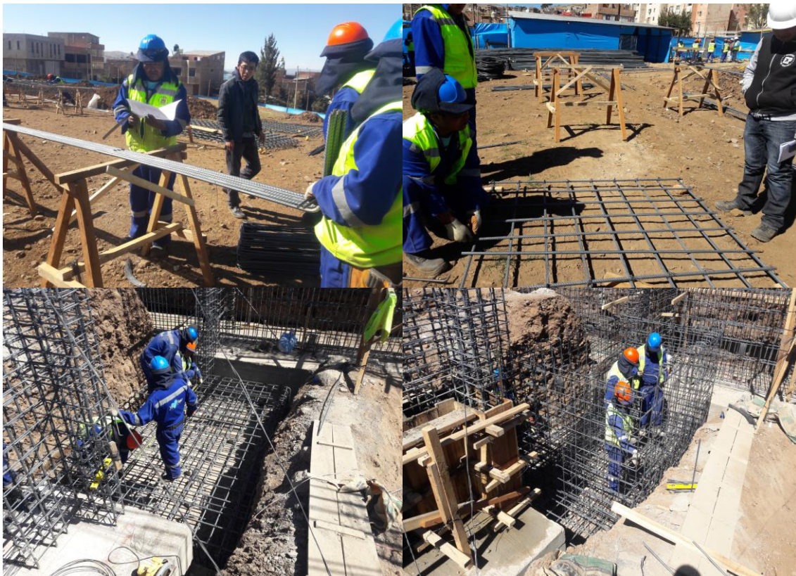
Figura N° 59: Habilitado de armadura de acero para tanque cisterna FUENTE: Elaboración propia
