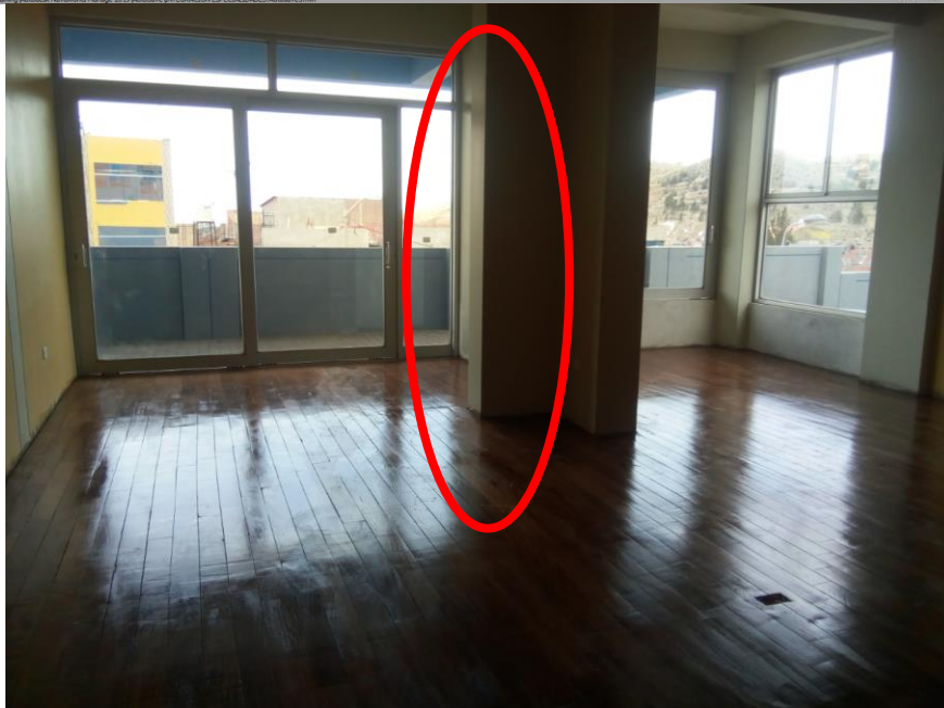
Figura N° 51: Vista final de tubería montante en falsa columna FUENTE: Elaboración propia
