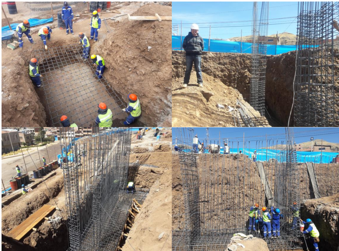
Figura N° 61: Armado de estructura de muro de contención en edificación FUENTE: Elaboración propia
