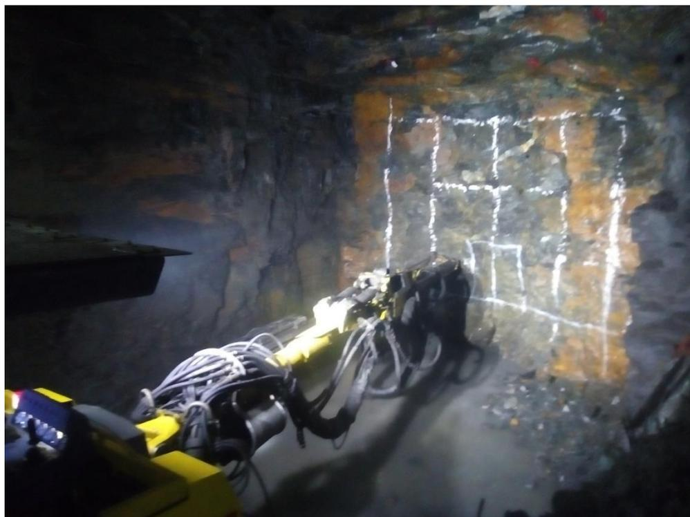
**Figura 19:** Perforación de malla en una sección de 3.5 m x 3.5 m.
