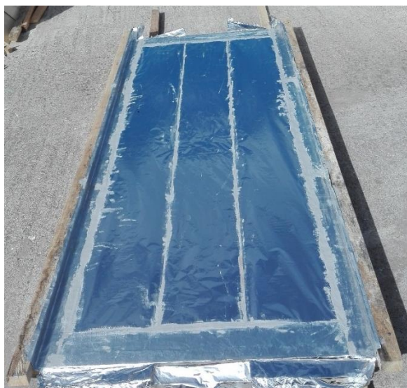
Figura 8. Construcción de la estructura del CSCA.
