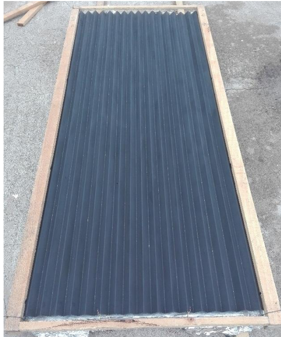
Figura 9. Instalación de la placa absorbente corrugada.
