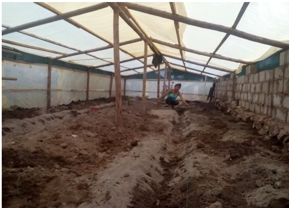
Figura 12. Preparación del terreno y marcado del campo experimental, el 24 de enero del 2019
