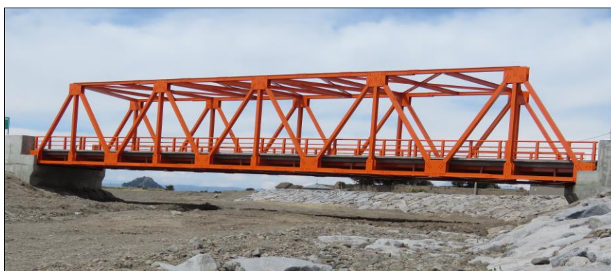
Figura 1 Vista de la Obra construcción del Puente Tanana y Accesos
