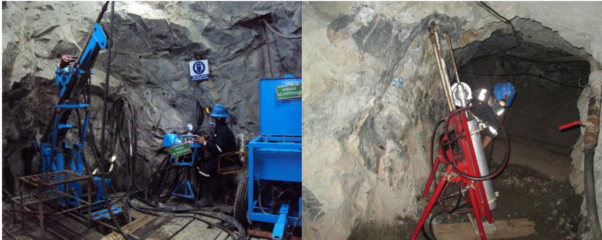
FIGURA N° 07: EQUIPO DE PERFORACIÓN DIAMANTINA.
