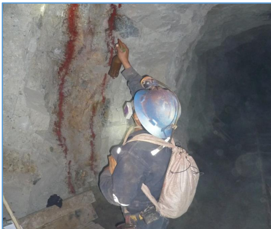
FIGURA N° 23: MARCADO DE ESTRUCTURAS.
