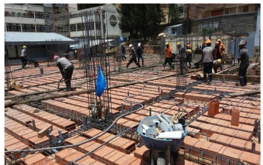
Figura: acero y ladrillo en losa aligerada, concreto en elementos horizontales (vigas y losa)
