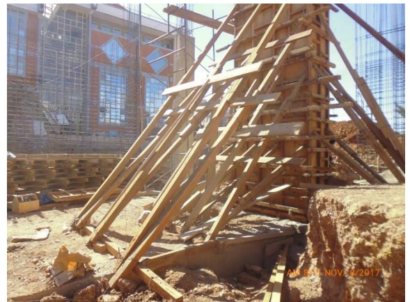
Figura: Encofrado y desencofrado de elementos verticales (Muros de contención y columnas)
