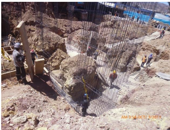
Figura: Acero Estructural en elementos verticales (muros de contención y columnas)
