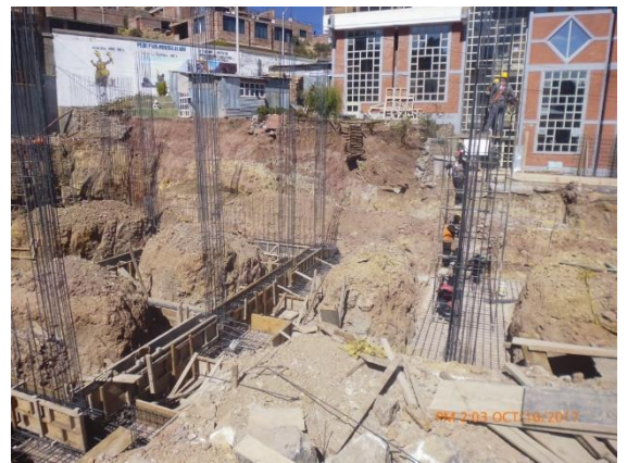
Figura: Acero Estructural en elementos verticales (muros de contención y columnas)
