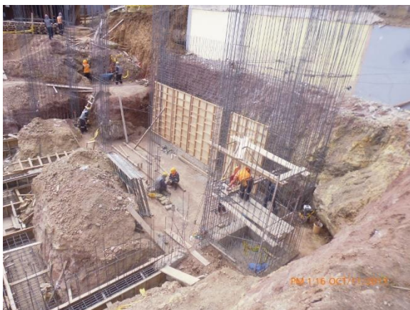
Figura: Encofrado y desencofrado de elementos verticales (Muros de contención y columnas)
