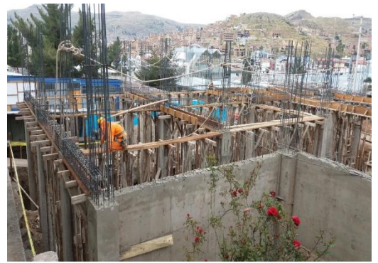
Figura: Encofrado de elementos horizontales (vigas y losa aligerada)
