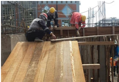
Figura: Encofrado de escaleras y acero en elementos horizontales (vigas)
