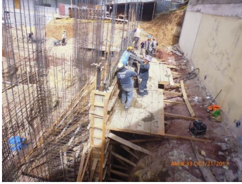
Figura: Concreto en elementos verticales (Muros de contención y columnas)
