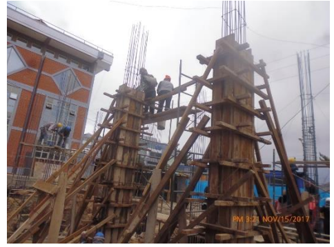
Figura: Concreto en elementos verticales (Muros de contención y columnas)
