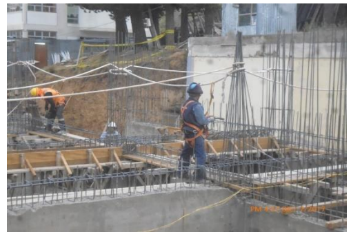
Figura: Encofrado de escaleras y acero en elementos horizontales (vigas)
