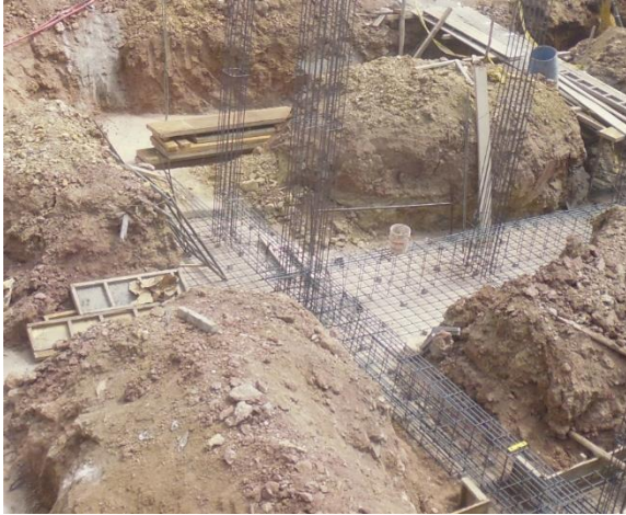
Fotos:, Acero y Encofrado de vigas de cimentación
