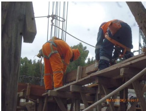
Figura: Encofrado de elementos horizontales (vigas y losa aligerada)
