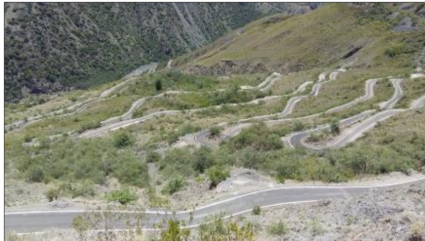
Figura 6: Curvas de Volteo en una sola Ladera en vista en Planta.
