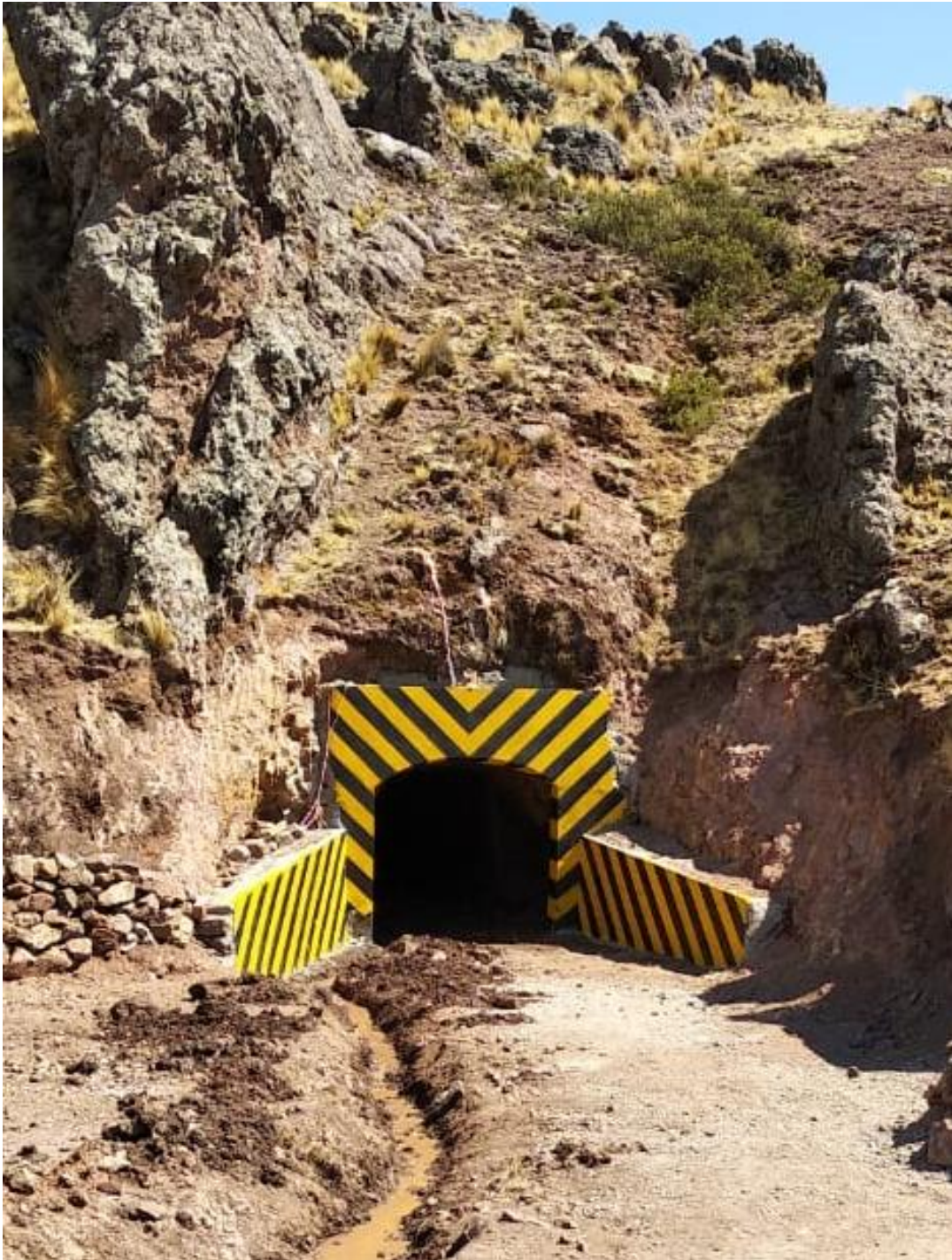
ANEXO A. Fotografía de la Bocamina principal mina escuela Carolina
