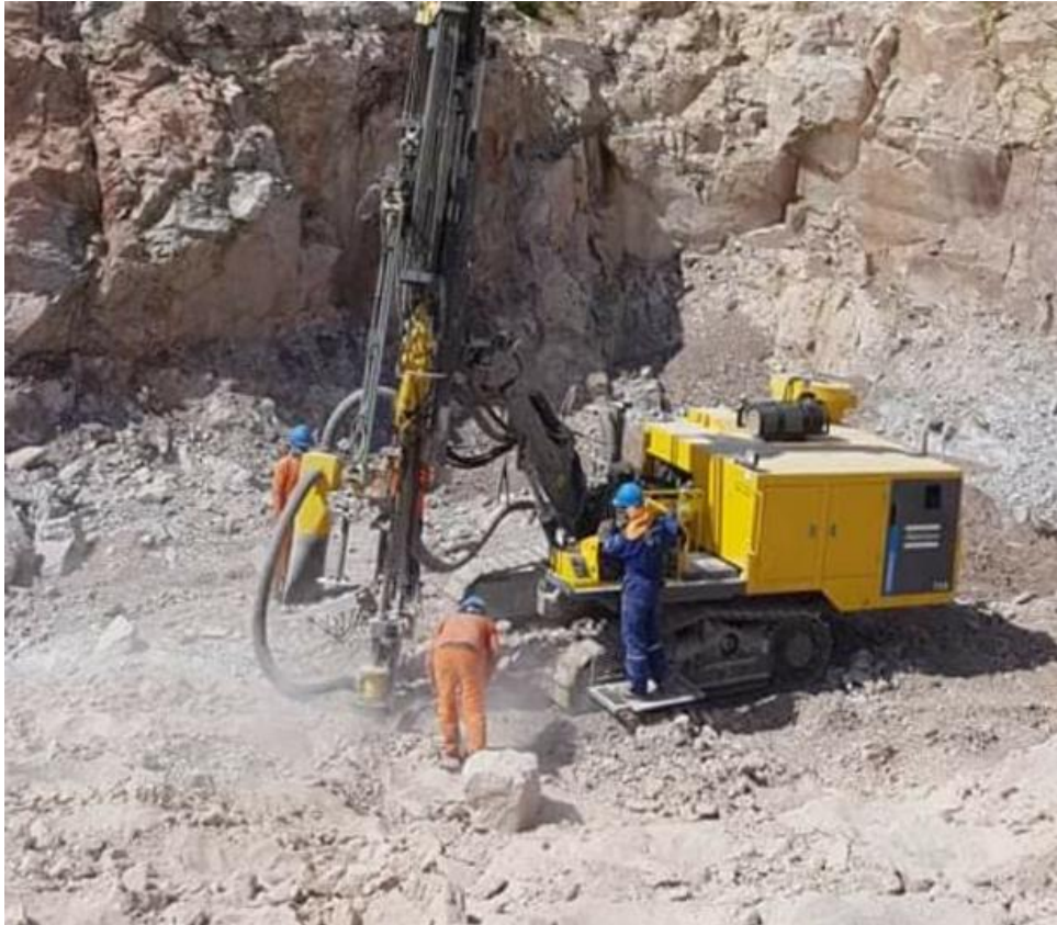
Figura 09: Perforación con equipos track-dril T25
