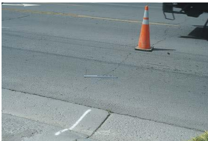
Figura 22. Tipo de falla ACP 6 – Fractura transversal de severidad moderada. Fuente: DIM LTPP (2014).
