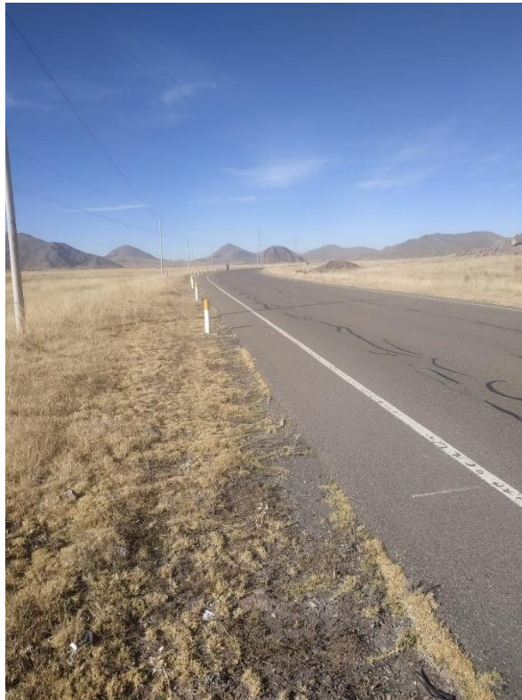
Figura 60. Relevamiento de datos en la sección de evaluación n.º 2 – fallas longitudinales. Fuente: Elaboración propia
