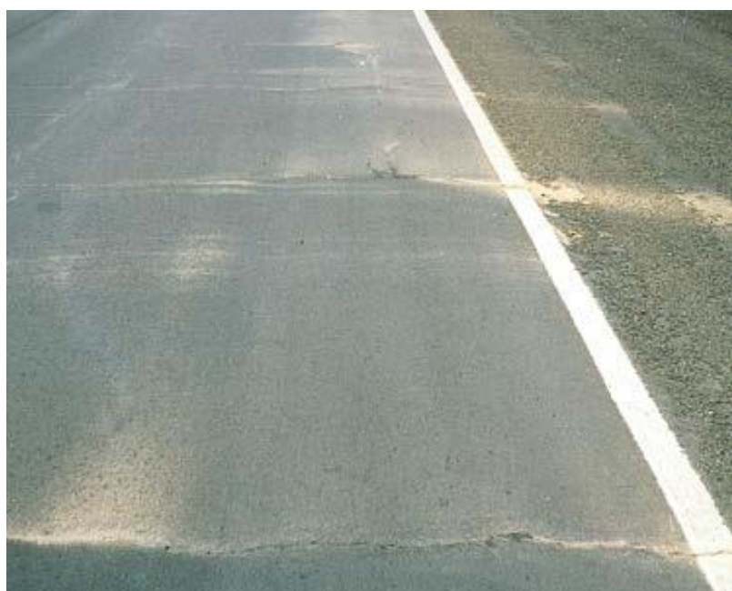
Figura 47. Tipo de falla ACP 14 – exudación y bombeo. Fuente: DIM LTPP (2014).
