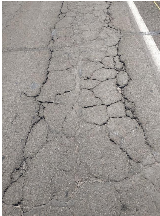
Figura 68. Relevamiento de datos en la sección de evaluación n.º 4 – fallas por fatiga, piel de cocodrilo. Fuente: Elaboración propia
