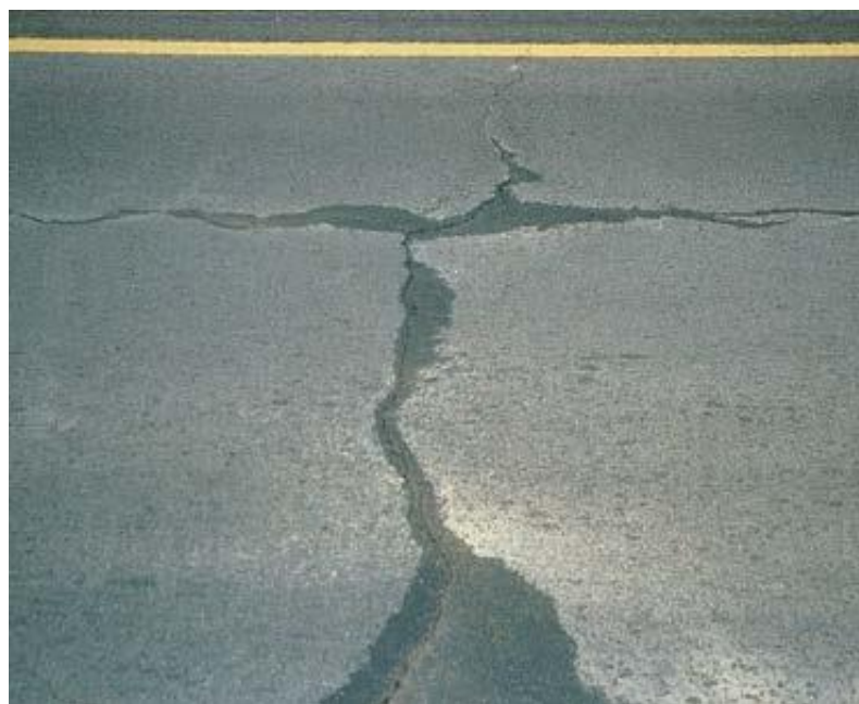
Figura 47. Tipo de falla ACP 14 – exudación y bombeo. Fuente: DIM LTPP (2014).
