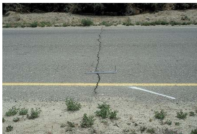
Figura 22. Tipo de falla ACP 6 – Fractura transversal de severidad moderada. Fuente: DIM LTPP (2014).
