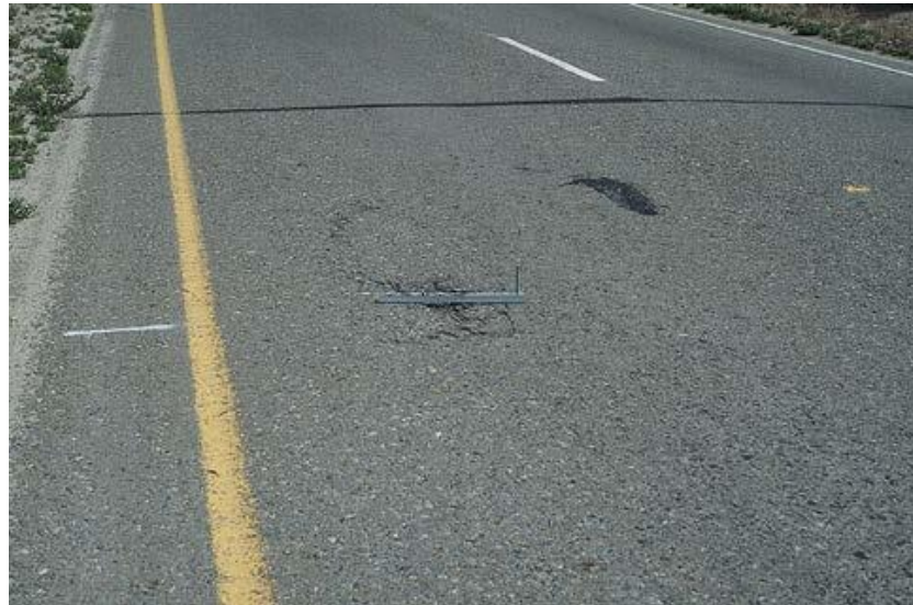
Figura 29. Tipo de falla ACP 8 –Bache de severidad baja. Fuente: DIM LTPP (2014).
