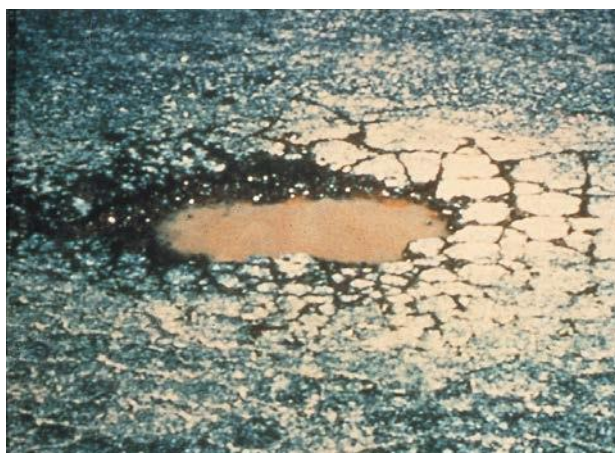
Figura 31. Tipo de falla ACP 8 –Bache de severidad moderada, toma con acercamiento. Fuente: DIM LTPP (2014).
