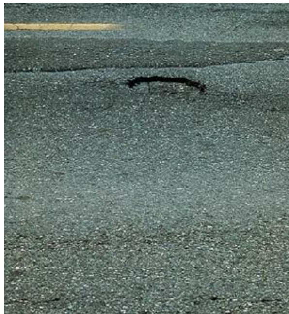
Figura 29. Tipo de falla ACP 8 –Bache de severidad baja. Fuente: DIM LTPP (2014).
