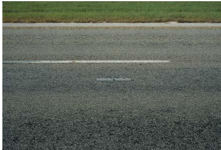
Figura 38. Tipo de falla ACP 11 – sangrado Decoloración. Fuente: DIM LTPP (2014).
