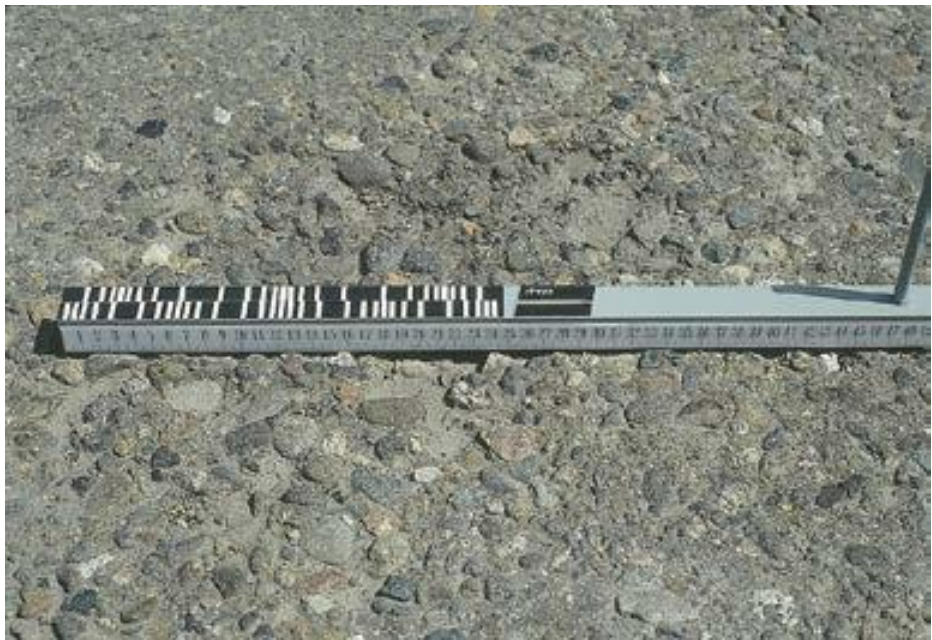
Figura 43. Tipo de falla ACP 13 – Perdida de agregado fino y grueso. Fuente: DIM LTPP (2014).
