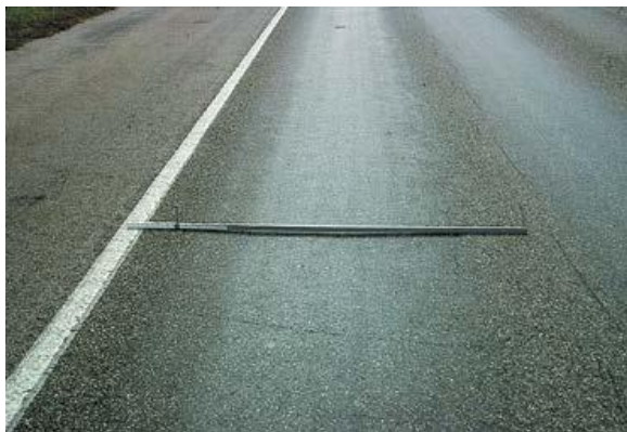
Figura 34. Tipo de falla ACP 9 – Ahuellamiento. Fuente: DIM LTPP (2014).
