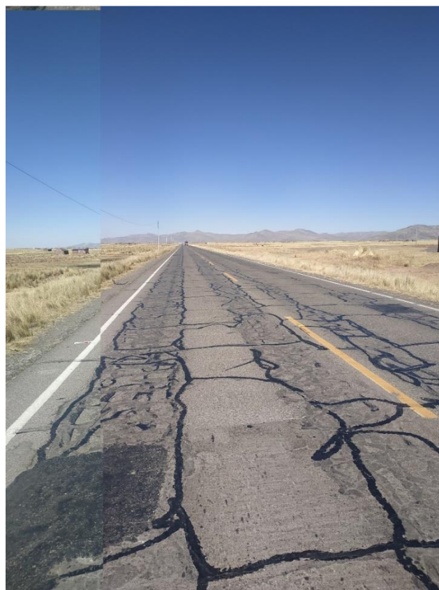
Figura 68. Relevamiento de datos en la sección de evaluación n.º 4 – fallas por fatiga, piel de cocodrilo. Fuente: Elaboración propia
