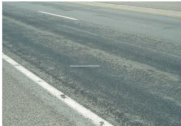
Figura 38. Tipo de falla ACP 11 – sangrado Decoloración. Fuente: DIM LTPP (2014).
