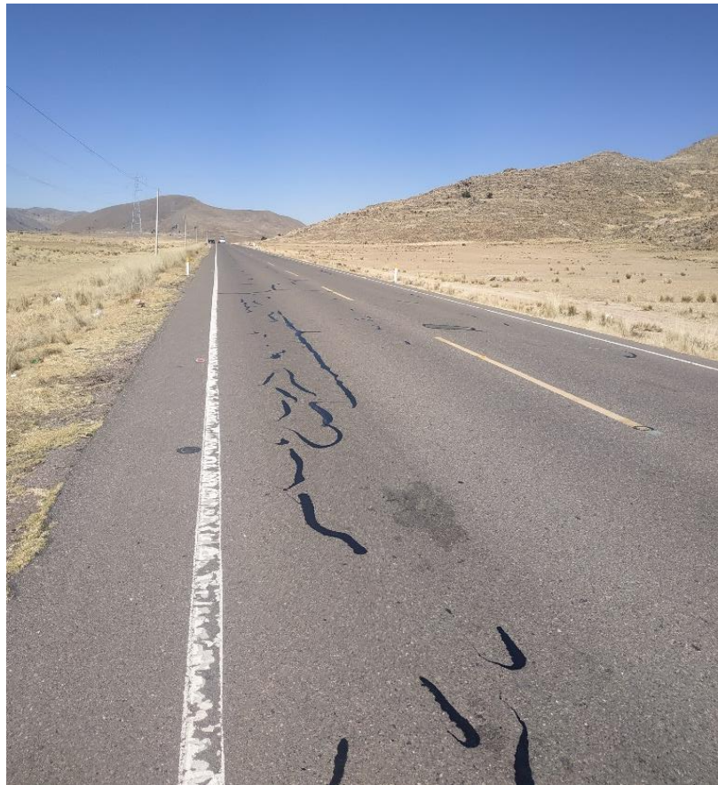
Figura 64. Relevamiento de datos en la sección de evaluación n.º 3 – fallas longitudinales. Fuente: Elaboración propia
