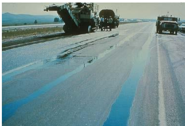
Figura 34. Tipo de falla ACP 9 – Ahuellamiento. Fuente: DIM LTPP (2014).
