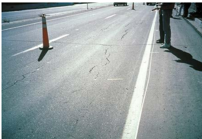
Figura 8. Tipo de falla ACP 1 – Fractura por Fatiga de baja severidad. Fuente: DIM LTPP (2014).
