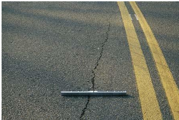
Figura 17. Tipo de falla ACP 4b – Fractura longitudinal fuera de la huella de llanta. Fuente: DIM LTPP (2014)
