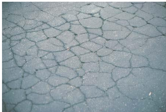
Figura 6. Tipo de falla ACP 1 – Fractura por fatiga. Fuente: DIM LTPP (2014).
