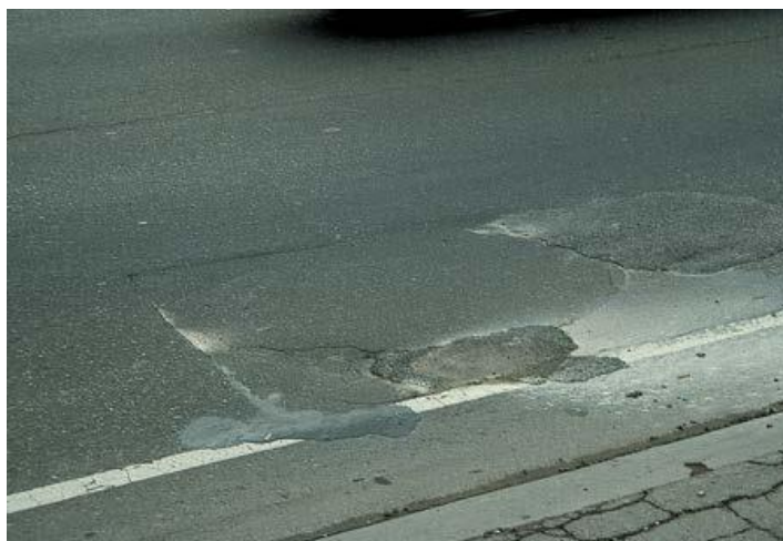
Figura 26. Tipo de falla ACP 7 –Parche de severidad baja. Fuente: DIM LTPP (2014).
