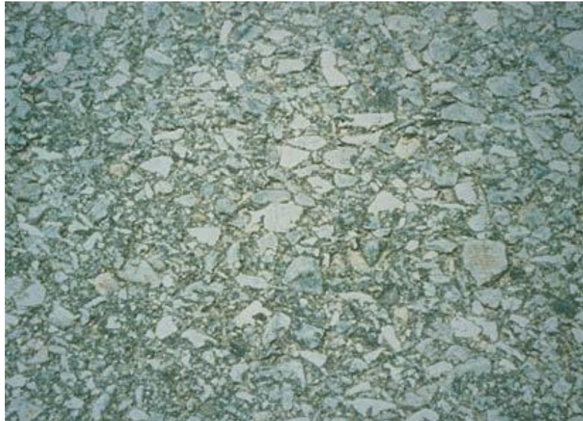
Figura 41. Tipo de falla ACP 12 – Agregado Pulido. Fuente: DIM LTPP (2014).
