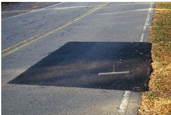
Figura 26. Tipo de falla ACP 7 –Parche de severidad baja. Fuente: DIM LTPP (2014).
