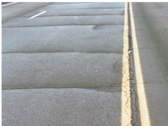
Figura 19. Tipo de falla ACP 5 – Fractura por reflejo en juntas de severidad alta. Fuente: DIM LTTP (2014).
