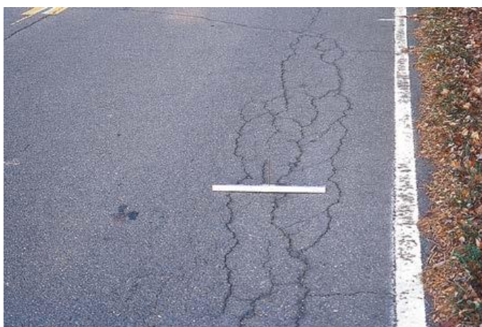
Figura 8. Tipo de falla ACP 1 – Fractura por Fatiga de baja severidad. Fuente: DIM LTPP (2014).
