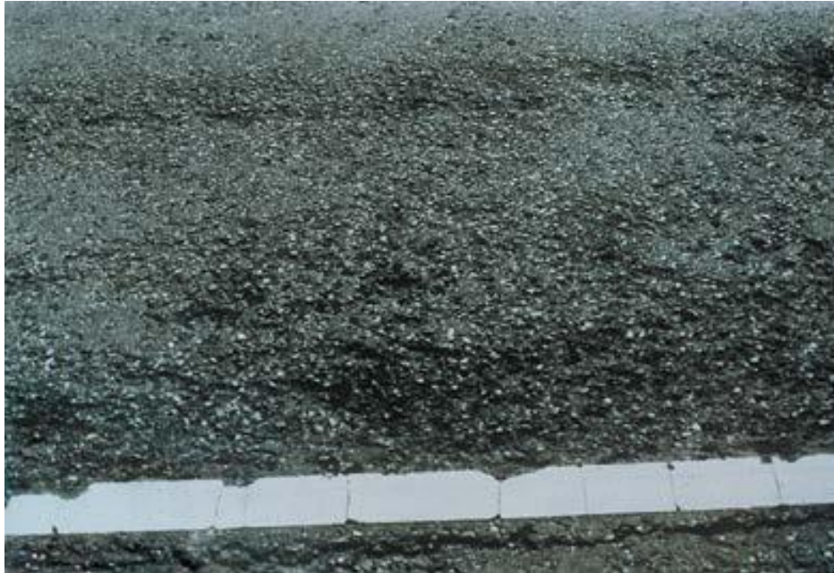
Figura 43. Tipo de falla ACP 13 – Perdida de agregado fino y grueso. Fuente: DIM LTPP (2014).
