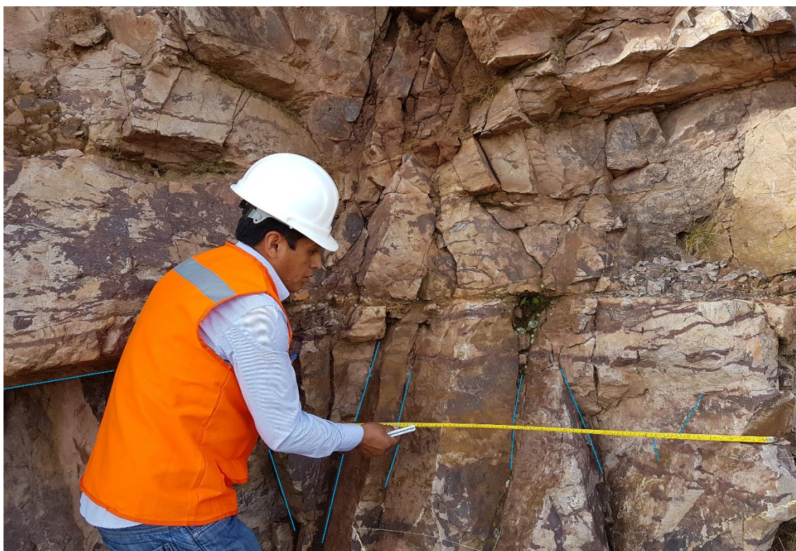
FOTO 06: En el afloramiento se realiza toma de actitudes macizo rocoso.
