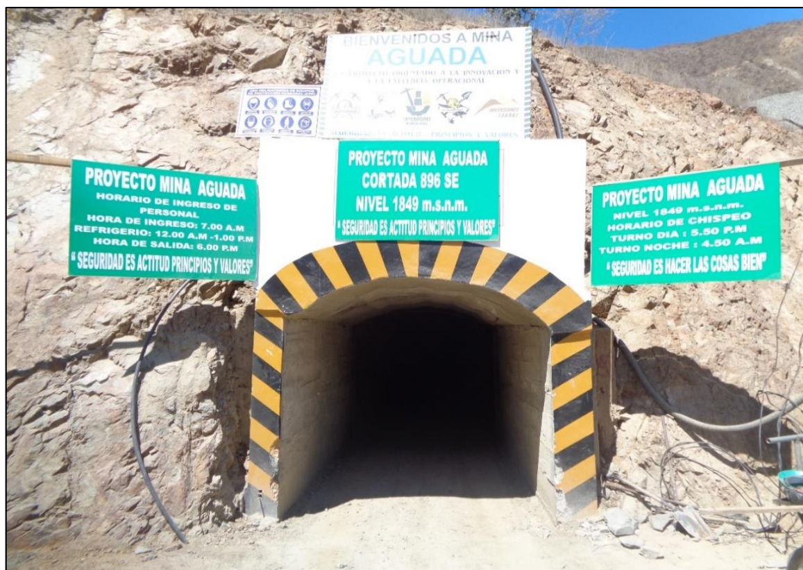
Figura 1: Portal de acceso a la Cortada 896 SE, nivel 1849 de la veta Esperanza – Mina Aguada. Emplazados en granodioritas.
