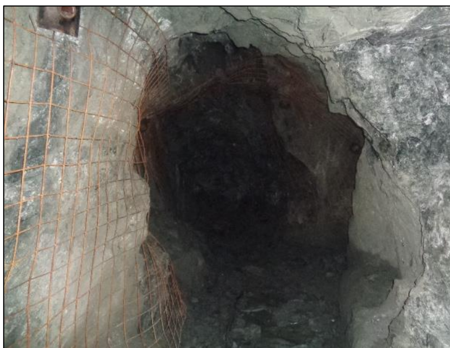
Figura 13: Instalación de malla electrosoldada, con Split set sistemático, en roca de tipo III-B.
