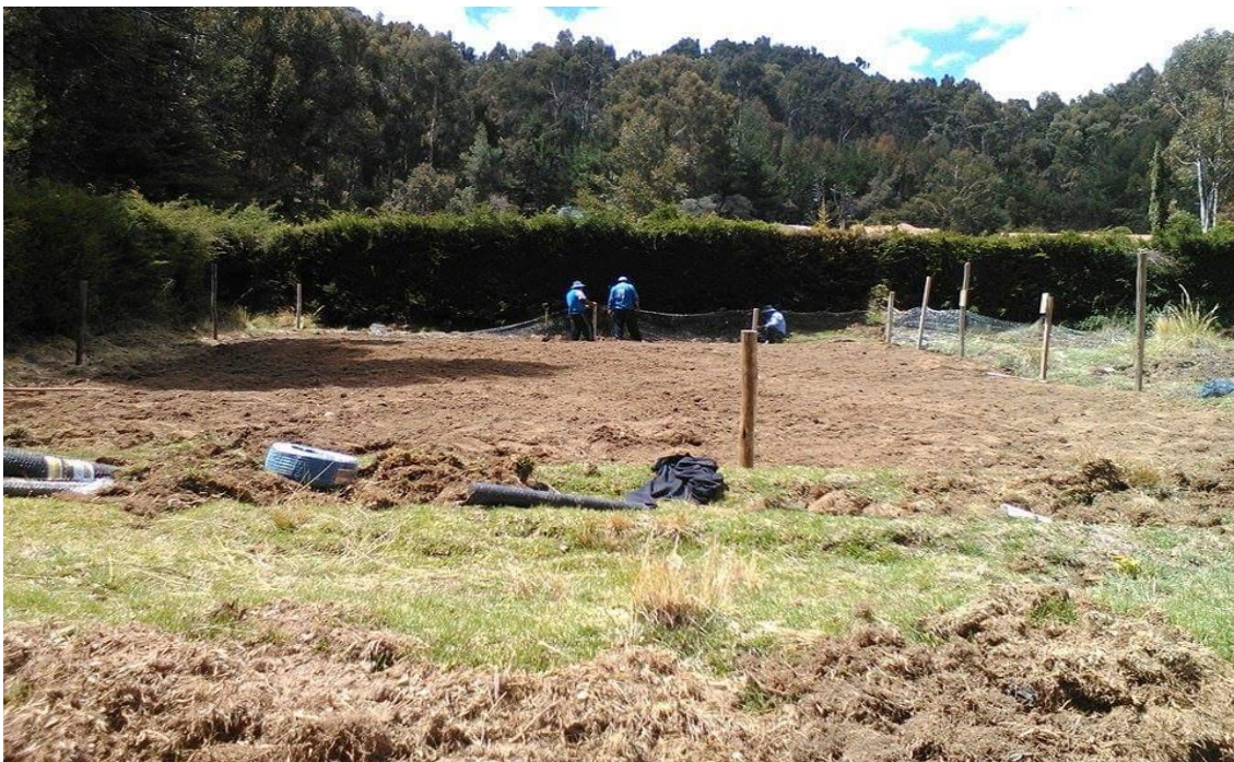
Limpieza y preparación del campo experimental
