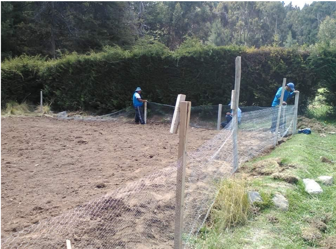
Cercado del campo experimental con malla metálica para la instalación.
