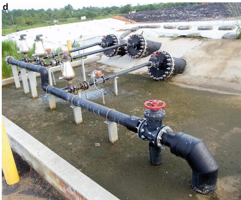
Figura 4. (a) piedras redondeadas usadas como material de drenaje LCRS. (b) colocación de arena para LCRS. (c) instalación de Geored en LCRS. (d) estación de bombeo lixiviado
