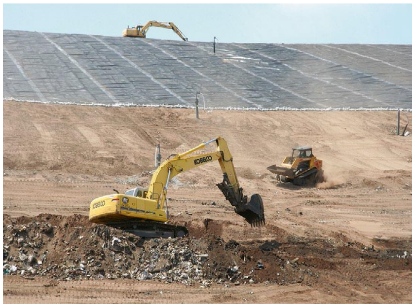
Figura 06. Construcción de un sistema de cierre en un relleno sanitario.
