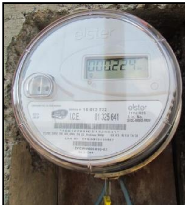
Figura N° 2.8: Registrador de Medidor.
