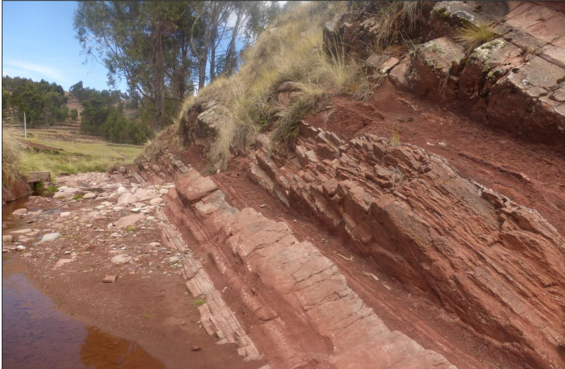
Figura 34. Erosión del suelo hasta afloramiento rocoso
