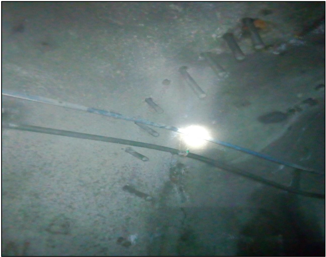
ANEXO N° 5: Perforación de taladros largos ascendentes
