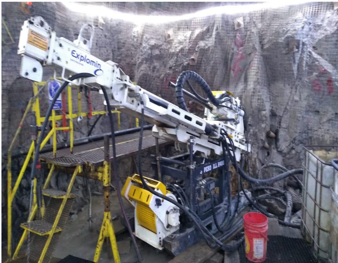
Figura 2.4: Máquina perforadora diamantina H400 – 03A.
